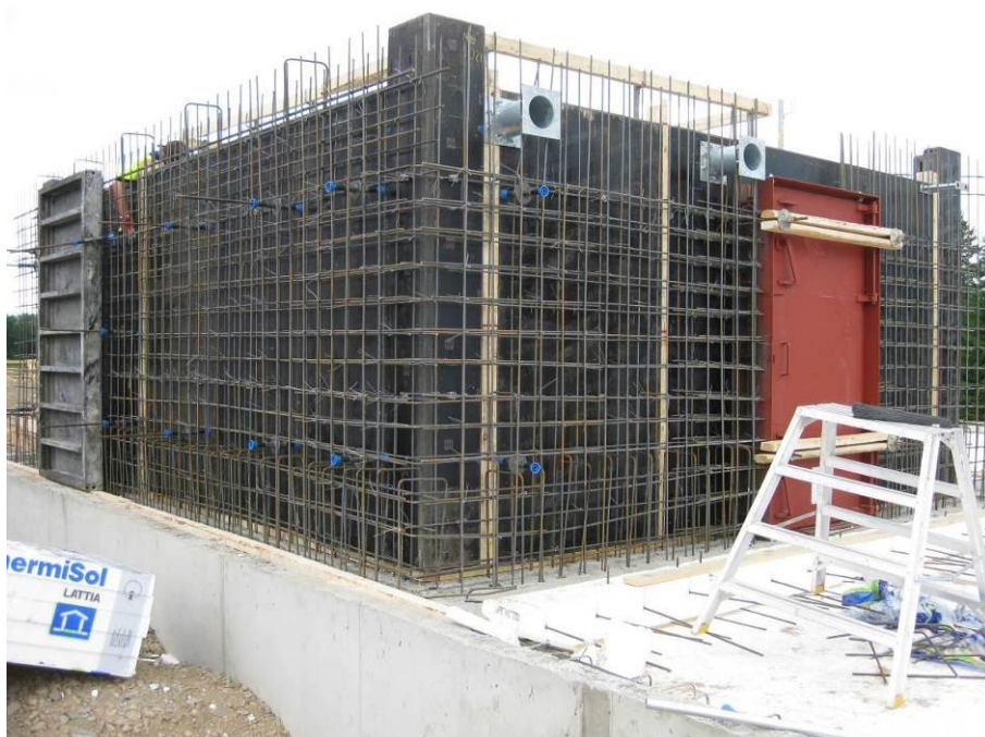
KUVA 19. Väestönsuojan toteutus manto-muottikalustolla
