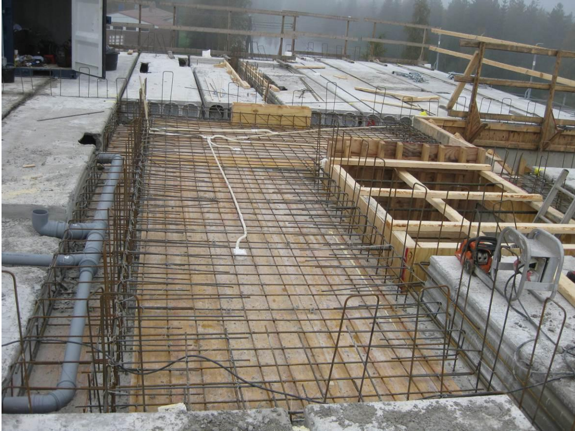
KUVA 15. Paikalla valettavan holvin raudoitus viemäri- ja sähköasennuksineen
