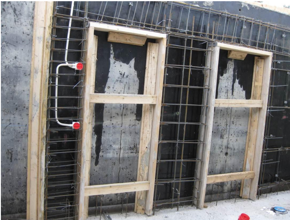
KUVA 14. Betoniseinä valmiina muotin tuplaukseen
