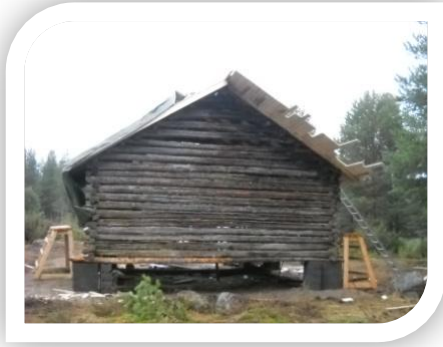
Kuva 4. Ladon korjattava pääty (Lehto 2011.)
