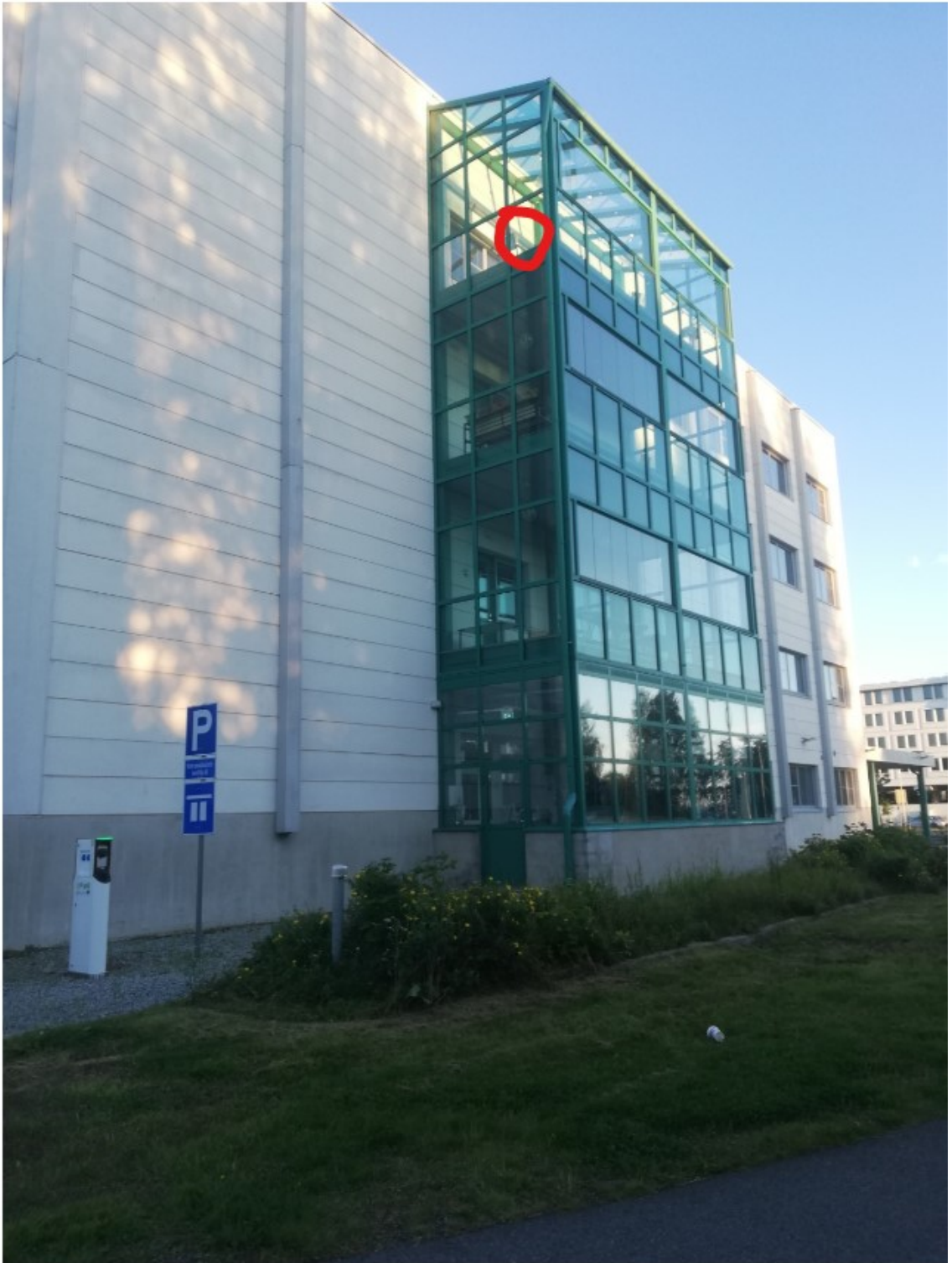
Kuva 7. Neljännen kerroksen länsipuolen mittauspiste
