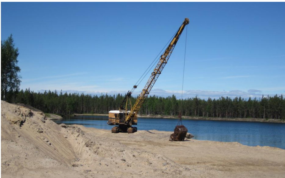
KUVA 3. Laahakaivuri nostamassa hiekkaa vesialueen pohjasta
