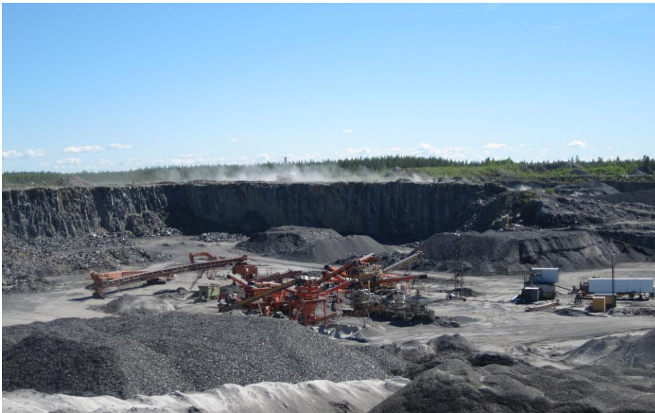
KUVA 4. Murskauslaitos kallion louhinta-alueella
