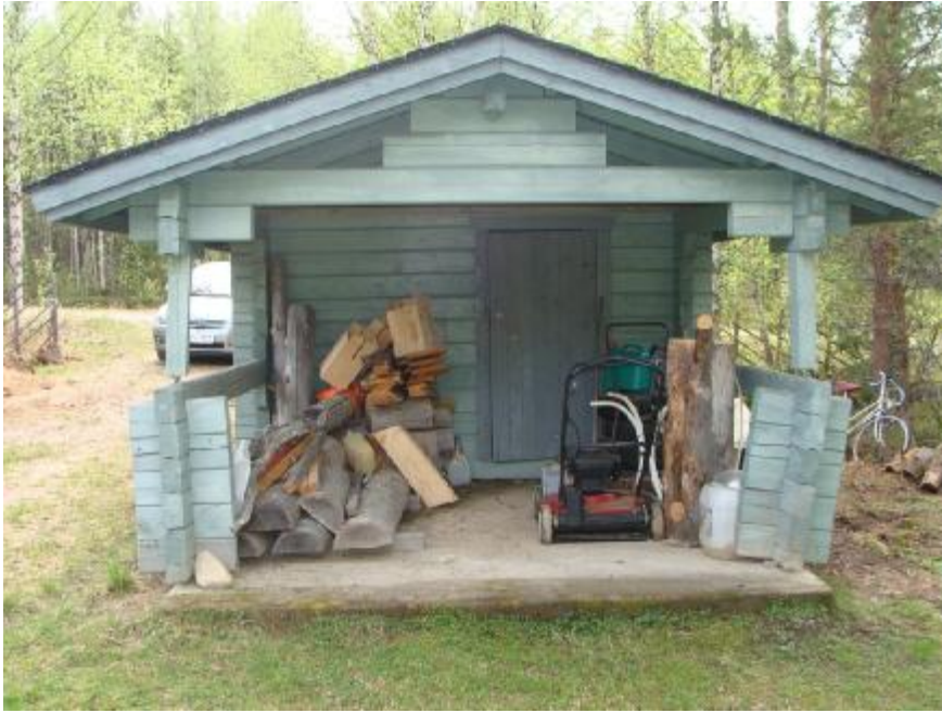
KUVA 8. Vanha piharakennus ennen muutosta
