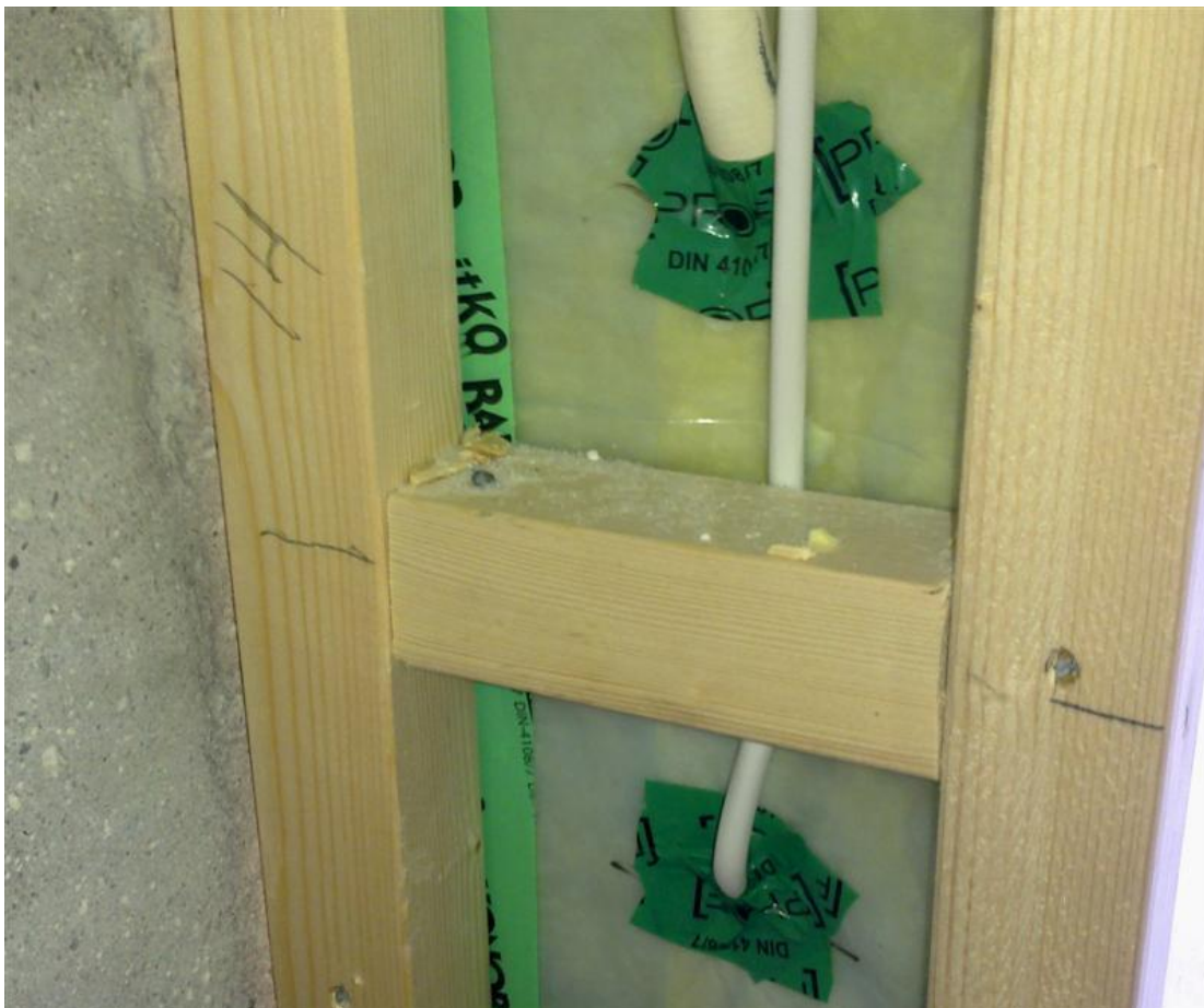
Kuvio 8. Lämpivientien teippaus ulkoseinässä
