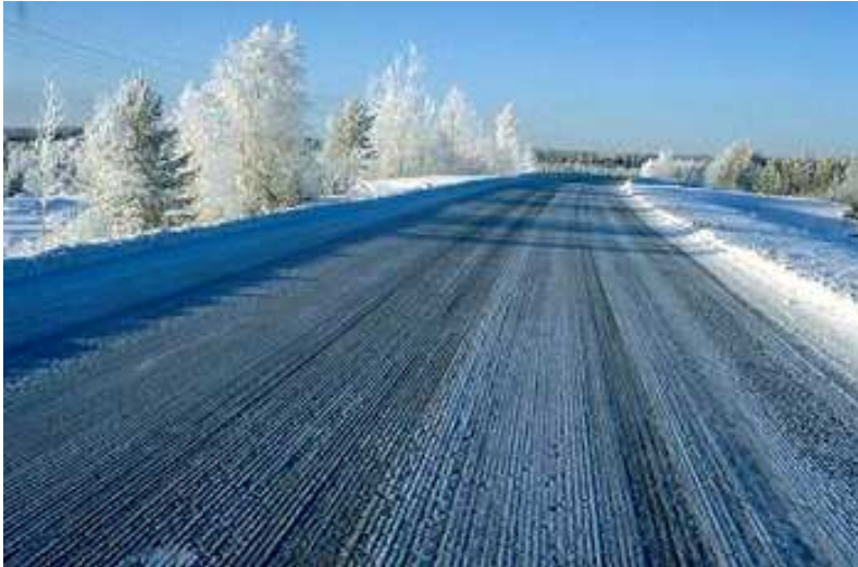
Kuva 11. II-luokan tie voi olla pääosin polannepintainen ja polanne urautunut. II-luokan teitä on Suomessa 19 916 km ja niillä kulkee liikenteestä 14 %. (Liikennevirasto 2012.)
