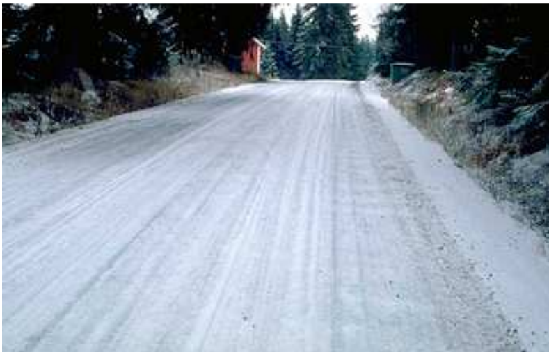
Kuva 12. III-luokan tiet ovat suurimman osan talviajasta polannepintaisia ja niissä voi olla paikoitellen uria. III-luokan teitä on Suomessa yhteensä 40 916 km ja koko Suomen liikenteestä niillä liikkuu 6 %. (Liikennevirasto 2012.)
