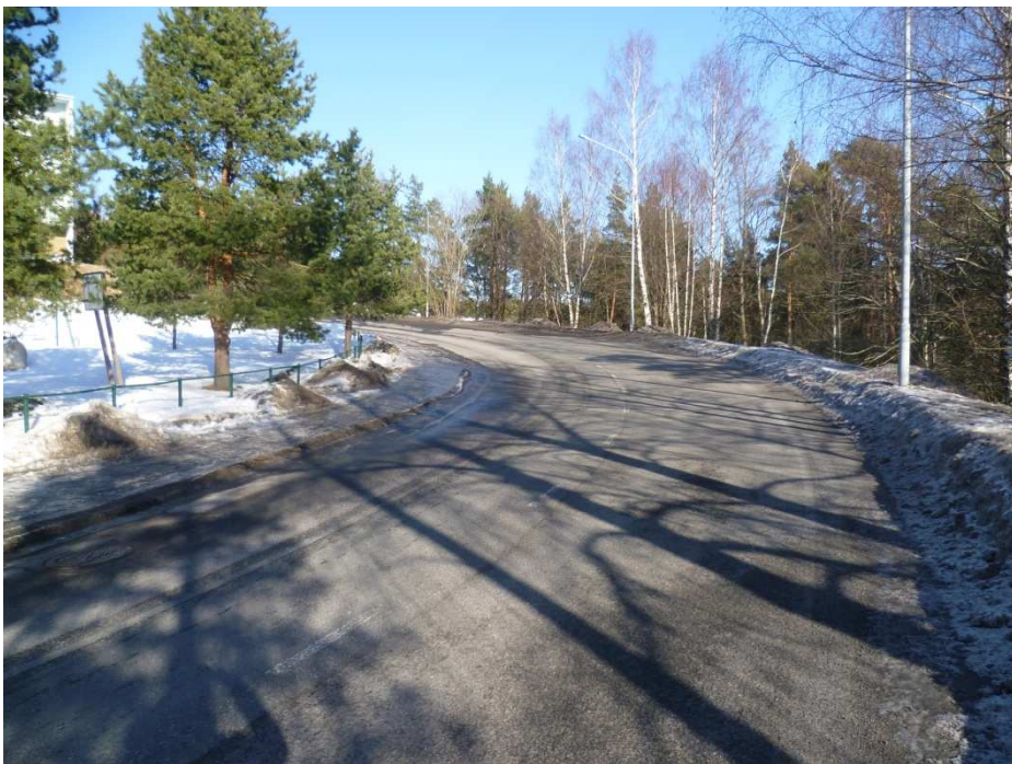
Kuva 15. Rusthollinrinteessä Uittamolla on jyrkkiä mutkia ja alamäkiä, jotka aiheuttavat liukkaalla kelillä vaaratilanteita.
