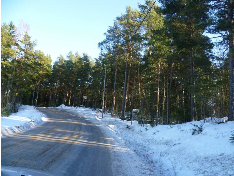
Kuva 14. Kaksikerrassa sijaitseva Vapparintie on erittäin mutkikas, kalteva, mäkinen ja alimitoitettu joukkoliikenteelle. Sijaintinsa vuoksi se on myös ollut liian myöhään hoidettava tie. Bussien on vaikea liikkua siellä hyvässäkin talvisäässä ja huonoissa olosuhteissa tie on täysin luokaton joukkoliikennekäyttöön.
