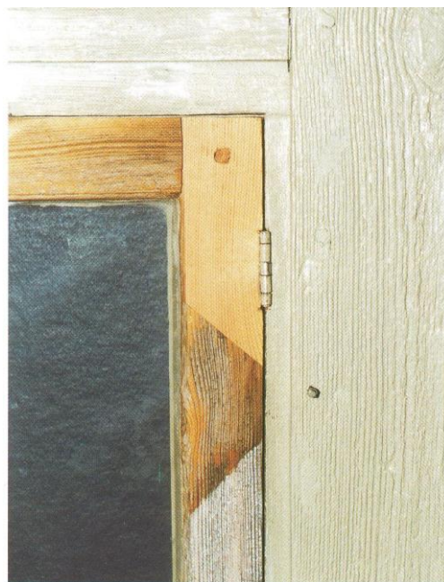
Kuvio 6. Kunnostettu ikkunapuite. (Vuolle-Apiala 2008, 106)
