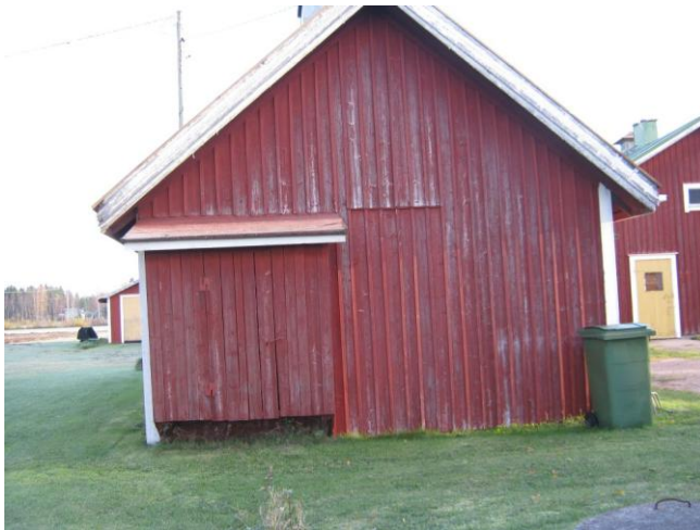
Kuva 11. Pienmetalli-, lasi- ja paristojätteiden keräilyrakennelma.
