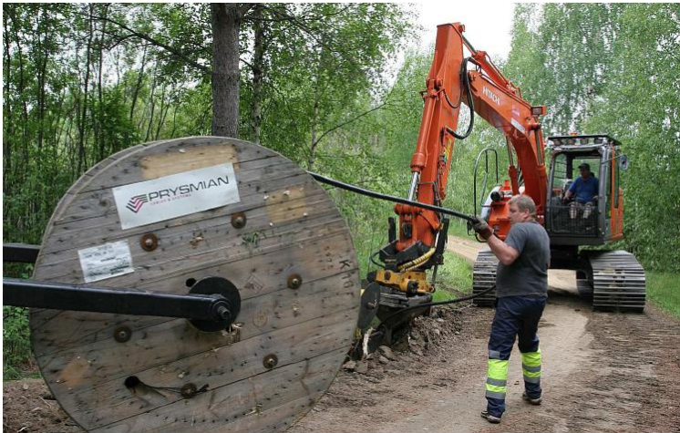
Kuva 4. Maakaapelin auras. (Lakervi & Partanen 2008,128)
