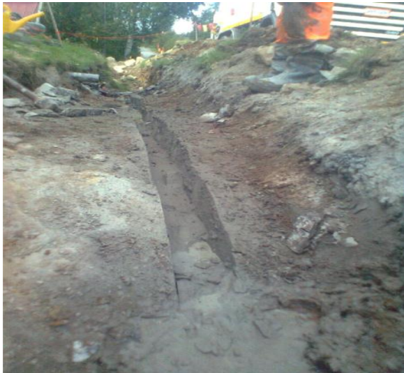
Kuva 6. Kallioon timanttisahalla leikattu kaapeliura. valokuva Tuomas Kamunen 2011
