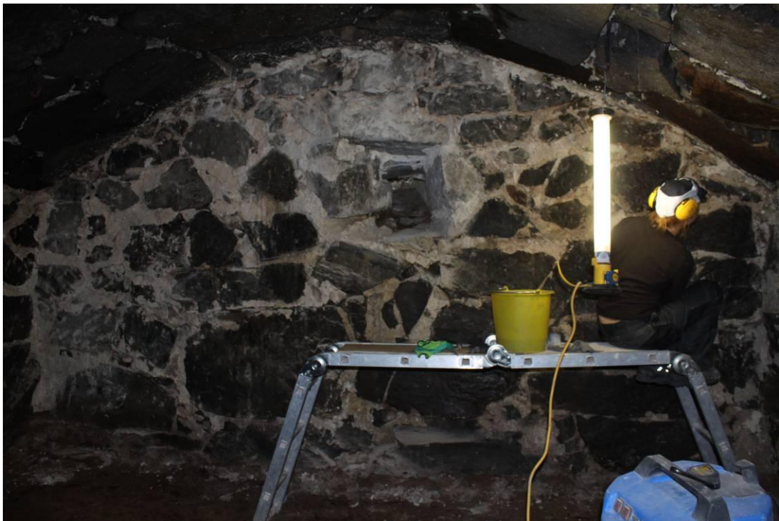
Kuva 5: Kellarin takaseinän ja kattoholvin puhdistus.
