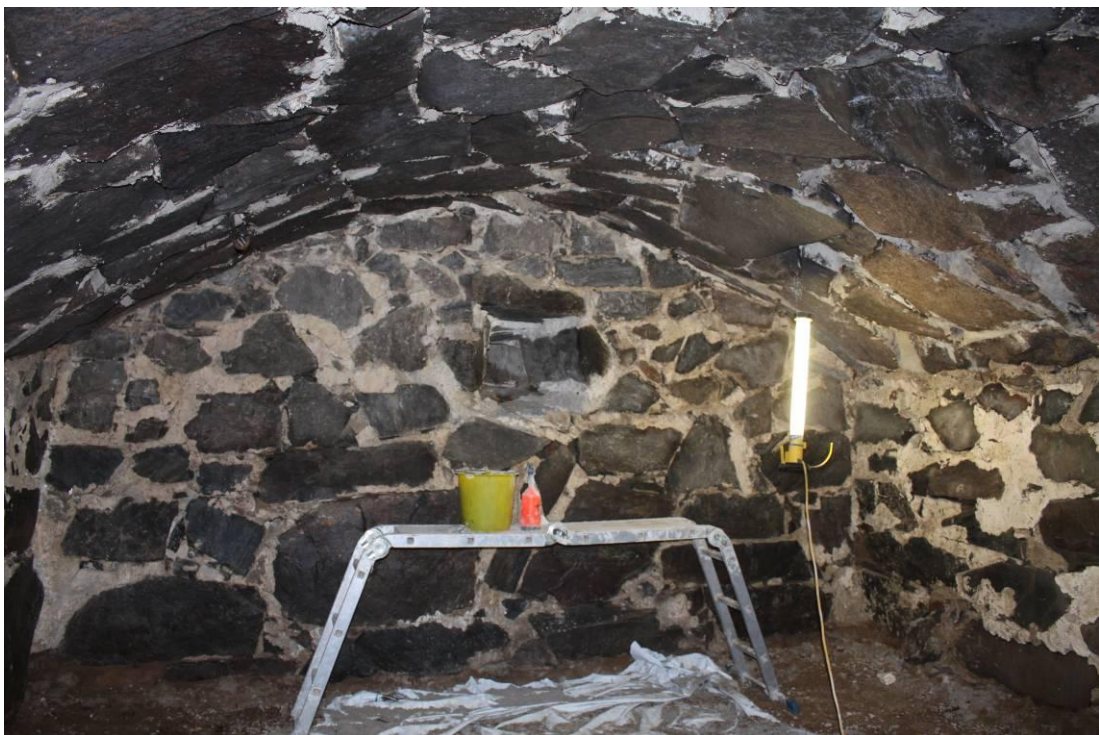
Kuva 6: Kellarin takaseinä ja katto työn loppuvaiheessa.
