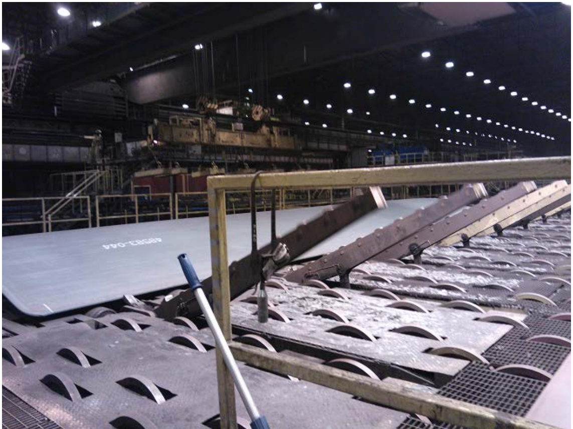
KUVA 7. Levynkääntäjät 2-tasolla. Taustalla siltanosturi.
