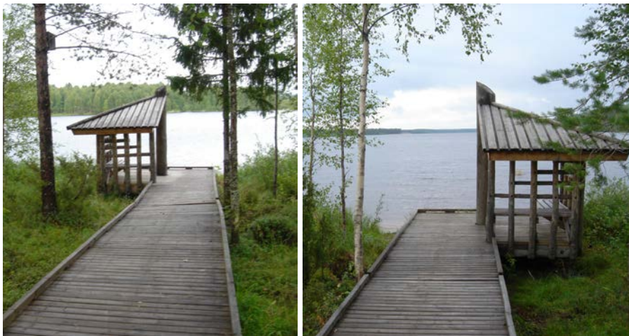
Hiljentymispaikka voisi näyttää esimerkiksi tältä. Katoksen puisia pystyrakenteita voitaisiin käsitellä tervamalla, sillä tervattua hirttä löytyy mm. rakennustapaohjeissa pihojen tukimuurisuosituksista. Kuvat: Pirjo Siipola.
