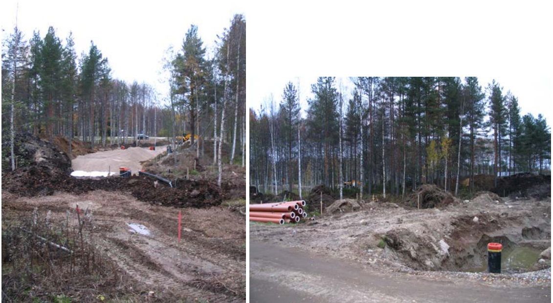
KUVAT 13 ja 14. Syksyllä 2010 Karhukunnaalle rakennettiin jo kunnallistekniikkaa. (Sini Vikström 3.10.2010.)
