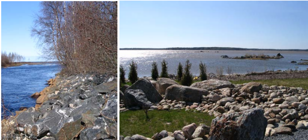
Kivikkoinen rantaelementti ehkäisee eroosiota, jota voi ilmetä levennettäessä saarta ympäröivää uomaa. Lisäksi se tuo rantamaisemaan monipuolisuutta ja näyttävyyttä. Kuvat: Sini Vikström.
