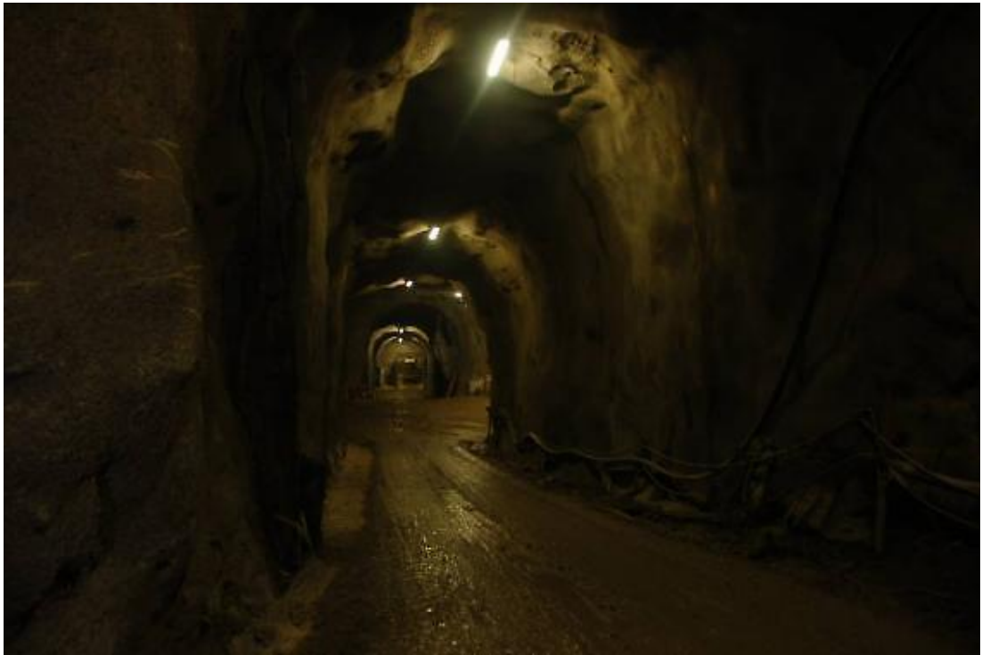
Kuvio 4. Kehäradan tunneli. ( http://www.vantaansanomat.fi/artikkeli/96589-keharadan-tunnelin-louhintatyo-lahes-valmis , 2012.)
