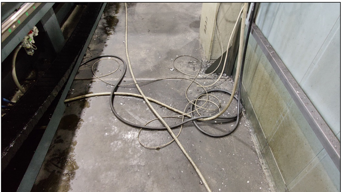
Kuva 16. CMA-porauskeskuksen johdot ja letkut ennen.
