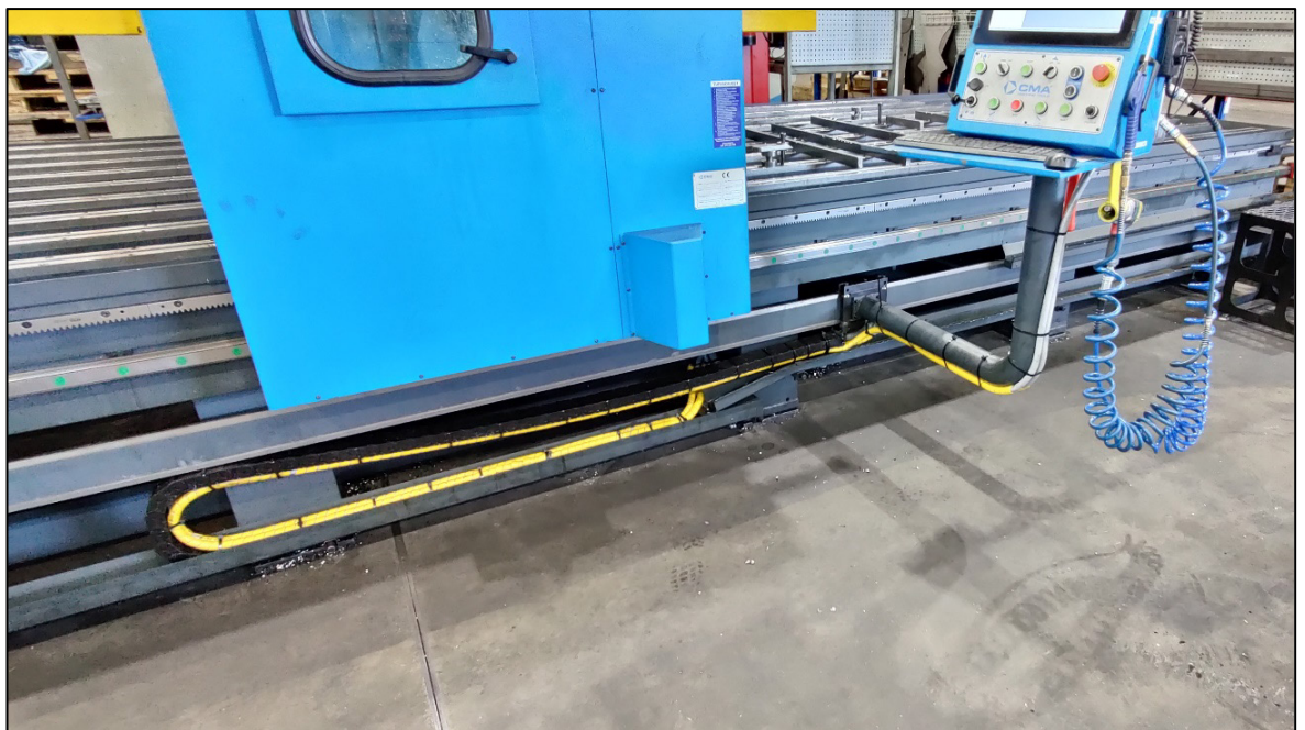
Kuva 40. Työpisteen paineilmaletkut jälkeen.
