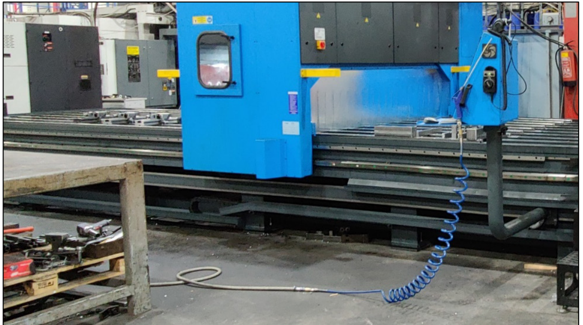
Kuva 36. CMA-porauskeskuksen paineilmaletku ennen.
