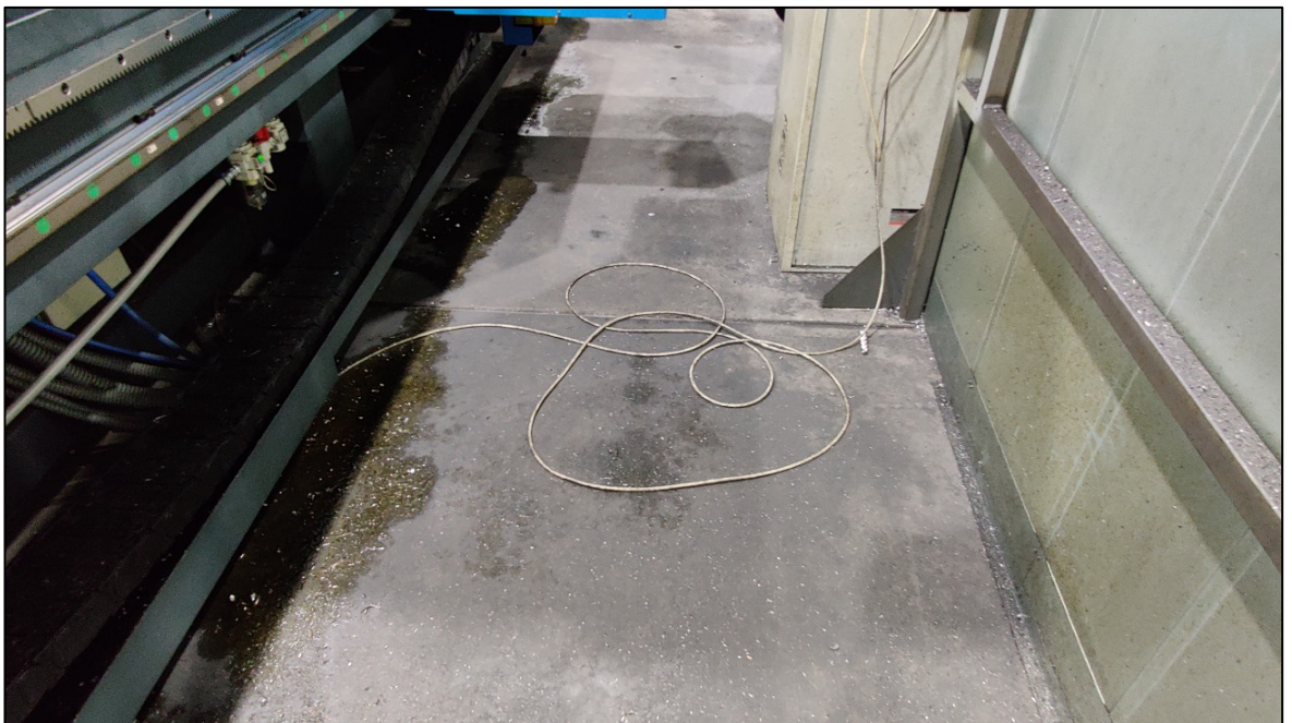
Kuva 18. CMA-porauskeskuksen johdot jälkeen.
