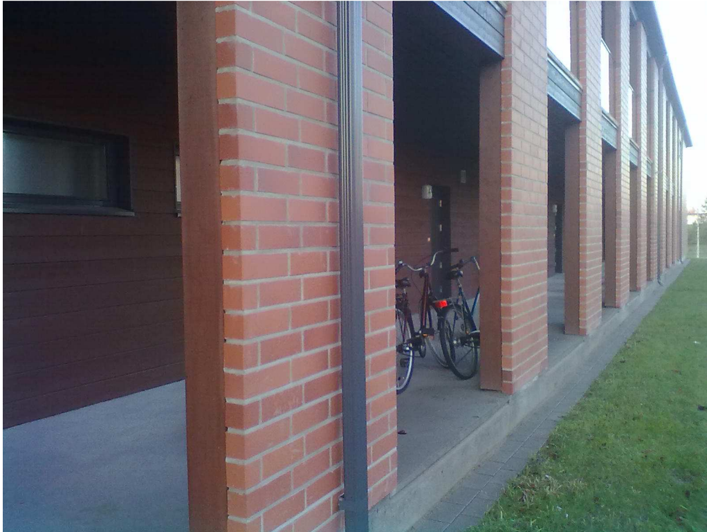
KUVA 3. Luhtikäytävän suuntaiset kantavat pieliseinät
