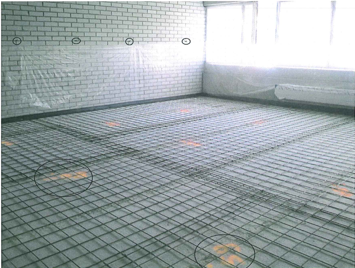
Kuva 4. Alustaan vaaitettu ontelolaatasto.
