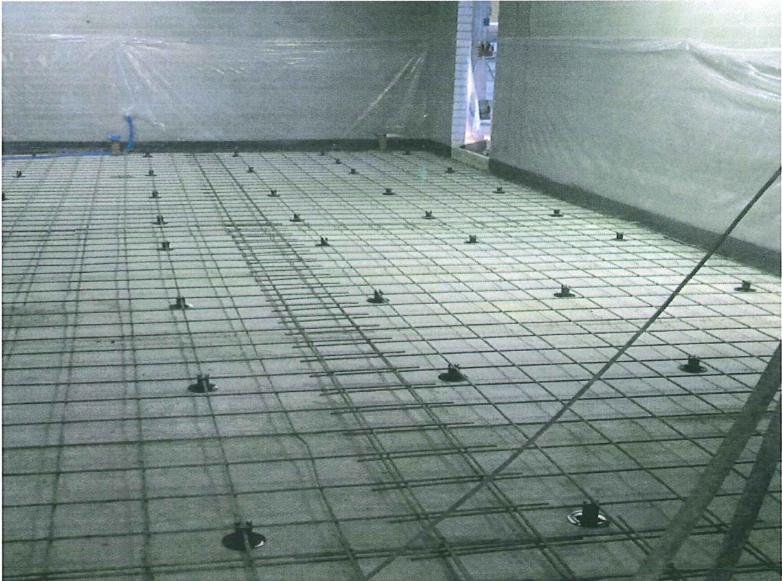
Kuva 5. Korokepaloin nostettu teräsverkko.
