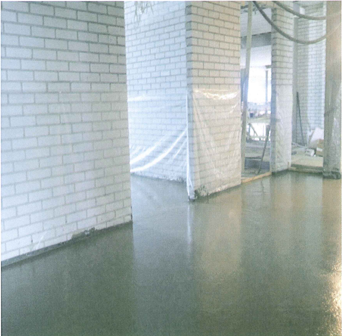
Kuva 7. Hierrettyä lattiapintaa, johon on levitetty jälkihoitoaine.
