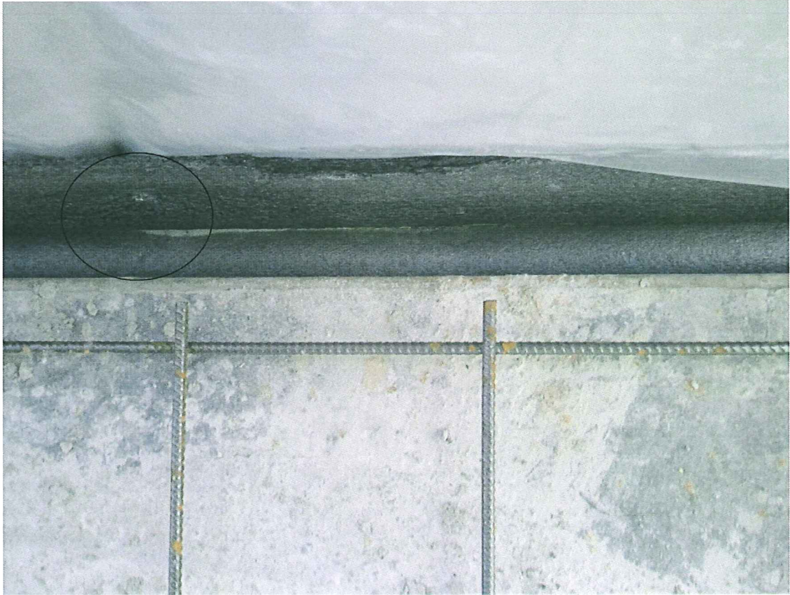
Kuva 9. Irrotuskaistat alumiininiiteillä kiinnitettyinä.
