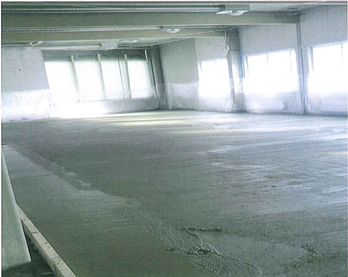
Kuva 6 Reunan hierto koneellisesti työsaumapuuta vasten.
