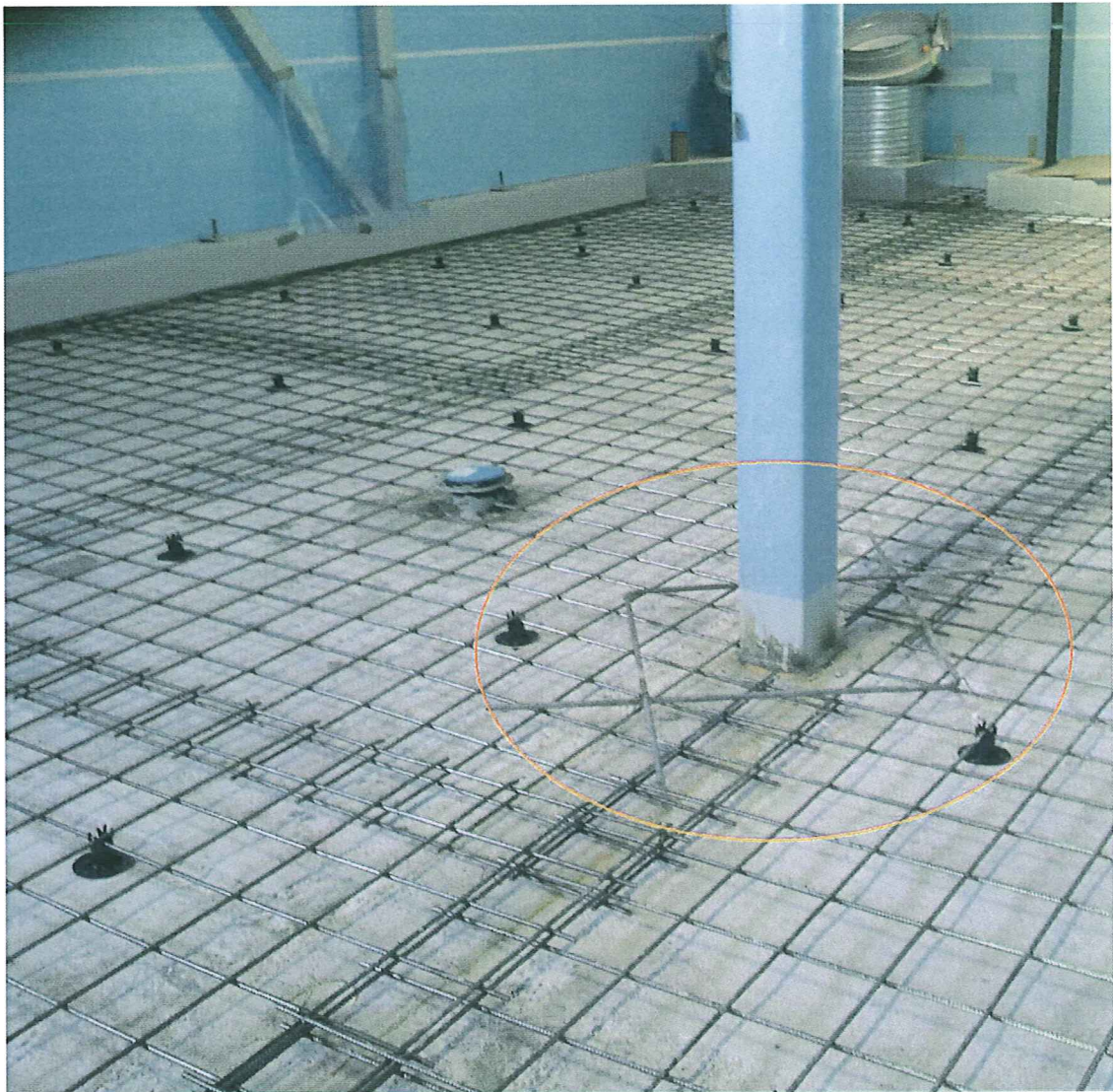
Kuva 9. Verkkoraudoitus sekä pilarin vahvikeraudoitus.
