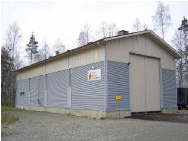
Kuva 3. Uimaharjun lämpölaite. (Kuva: Enon energiaosuuskunta)
