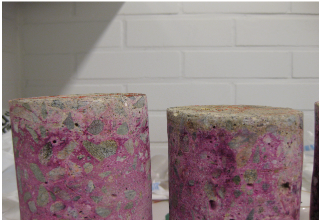
Kuva 13. Indikaattoriliuoksen osoittamaa karbonatisoitumista. Värjäntymätön kohta lieriön yläreunassa on vaurioitunut.
