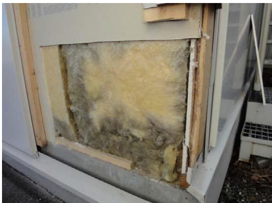
Figur 1. Isoleringen har blivit mörkare i färgen när den har varit utsatt för konvektion. /3/
