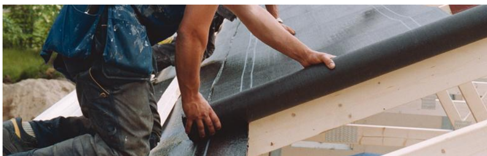
Figur 30. Montering av underlagsdukar. /7/
