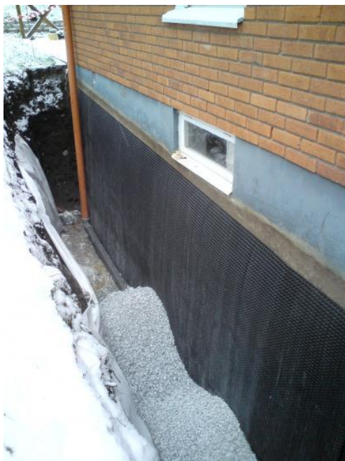
Figur 10. Platonmatta monterad mot källarväggen. /8/
