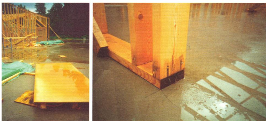
Figur 37. Dåligt väderskyddad byggnad. /2/
