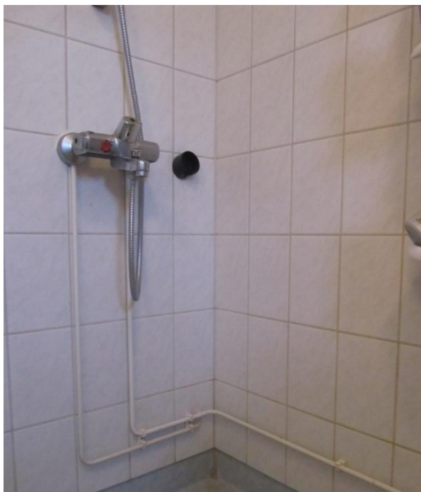
Figur 31. Genomförningar och fästen placerade bredvid duschen.
