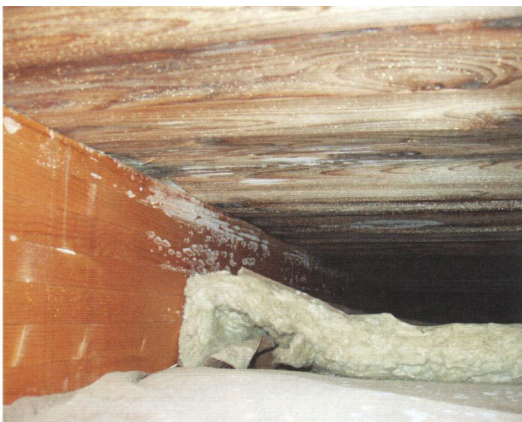
Figur 36. Mellantaket har fått fuktskador och rötskador. /2/
