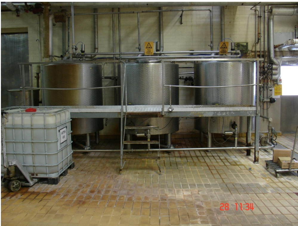
Figur 13: Diskcentralen: sterilvatten, salpetersyra och lut.
