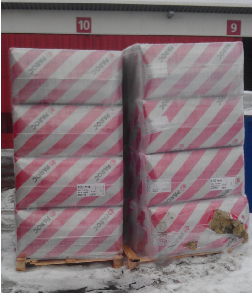
Kuva 5: Eristelavoja, jotka ovat tilan puutteen vuoksi vailla suojaa.
