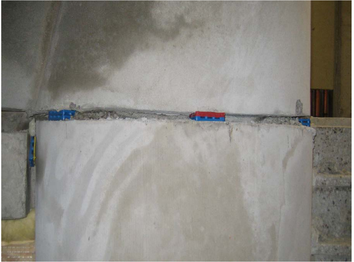
KUVA 4. Asennuspalojen avulla Elemento 6 -porraslementti asennetaan oikeaan korkeusasemaansa.
