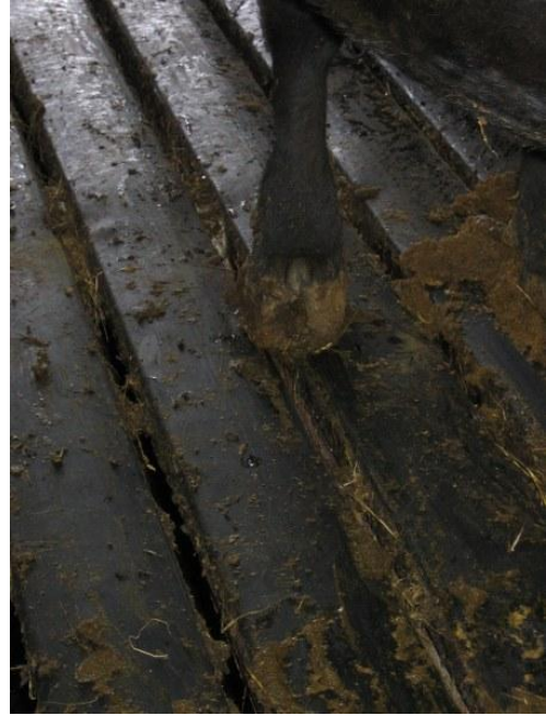
KUVIO 3. Betonipalkit päällystetty koko pituudeltaan kumiluiskilla
