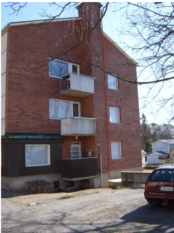
Kuva 3. Luoteen puoleinen pääty.
