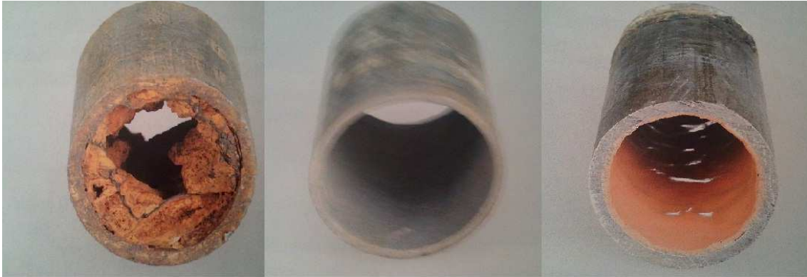
KUVA 4. Viemäriputki pinnoituksen eri vaiheissa (5)
