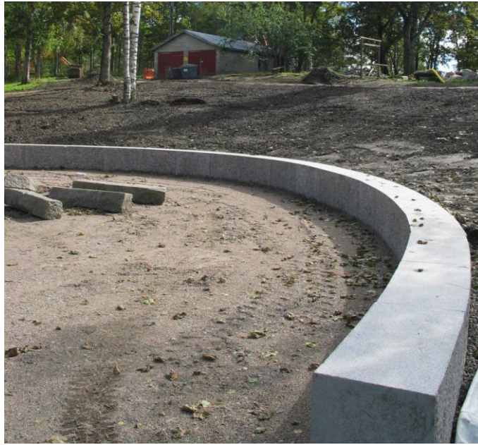
Kuva 15. Muuri vasta asennettuna. Kuva Tarja Hynninen.
