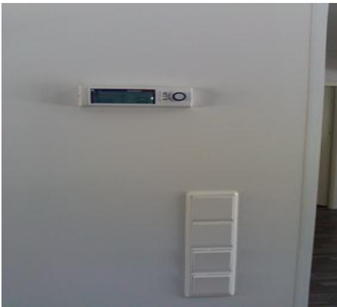
Kuva 25. Siirretty Ouman Plus -näyttö olohuoneen seinällä.
