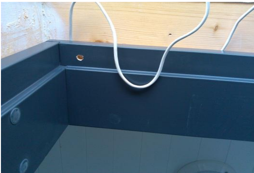
Kuva 12. Kuorivalvonnan anturan asennus ovikarmiin.
