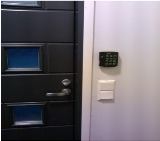
Kuva 17. Koodisulkija asennettuna pääsisäänkäyntioven viereen.
