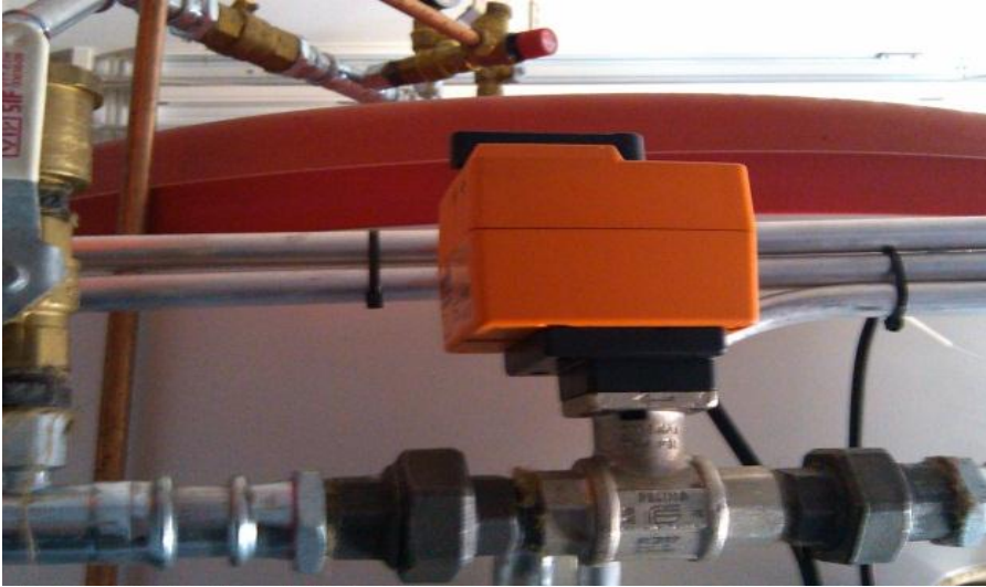
Kuva 20. L1-piirin shunttimoottori kytkettynä.
