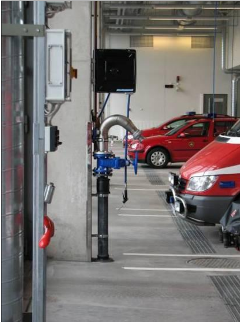
KUVA 9. Täyttöputkisto maassa muoviputkella
