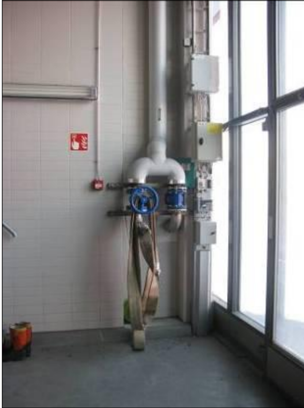
KUVA 8. Täyttöputkisto pinta-asennuksena
