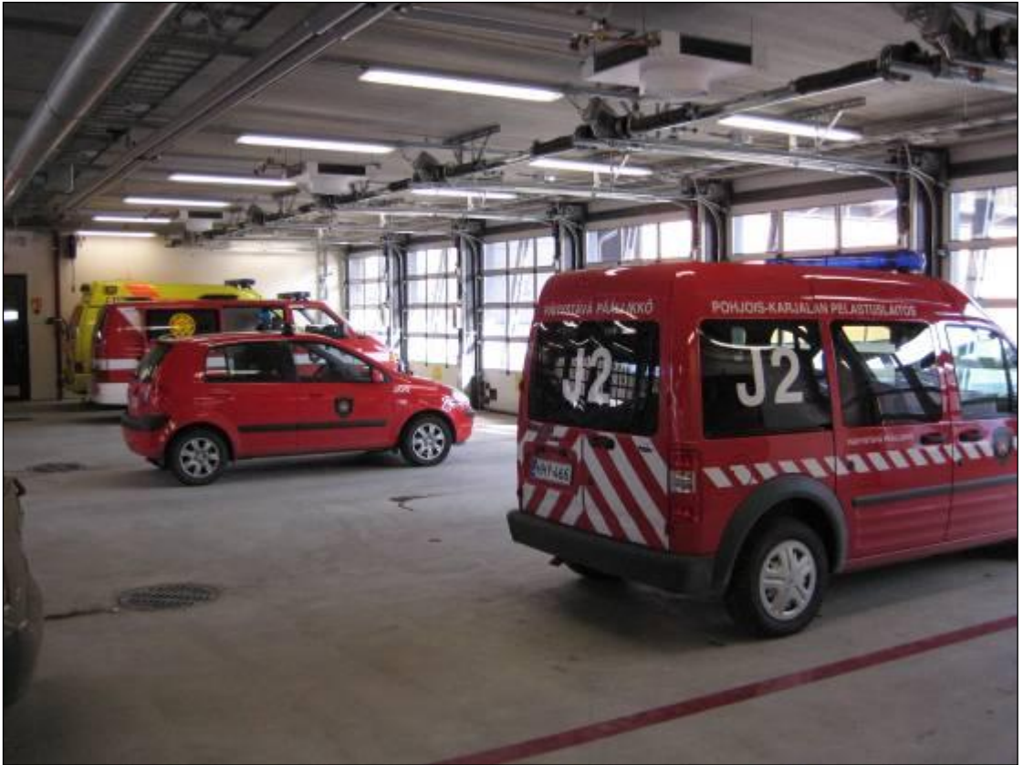
KUVA 1. Ovet avautuvat katon suuntaisesti
