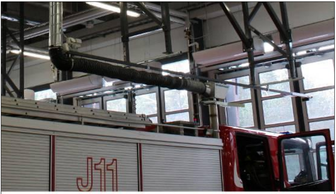
KUVA 16. Pakokaasurata Magnastack-imuvaunulla /15/
