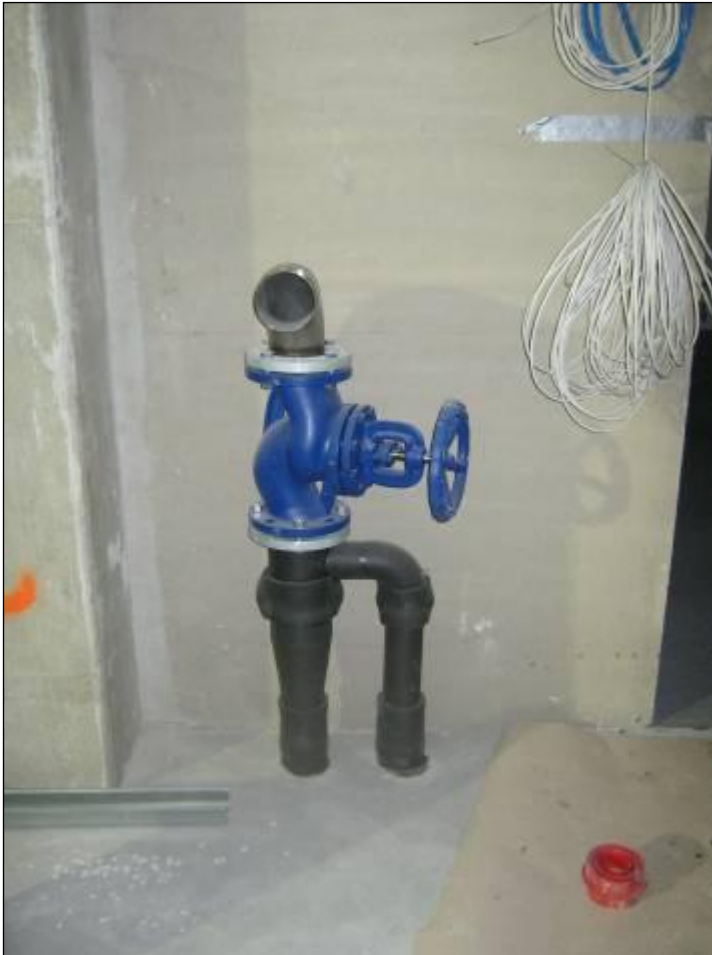
KUVA 15. Täyttöputkisto maassa kahdella muoviputkella. Putkesta puuttuu vielä kannakointi seinästä sekä kynsiliitin.
