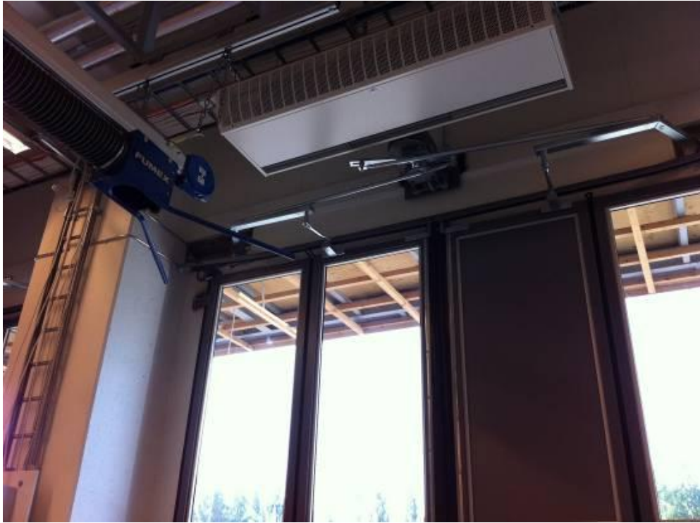
KUVA 22. Oviverhopuhaltimen sijoittaminen oven yläpuolelle
