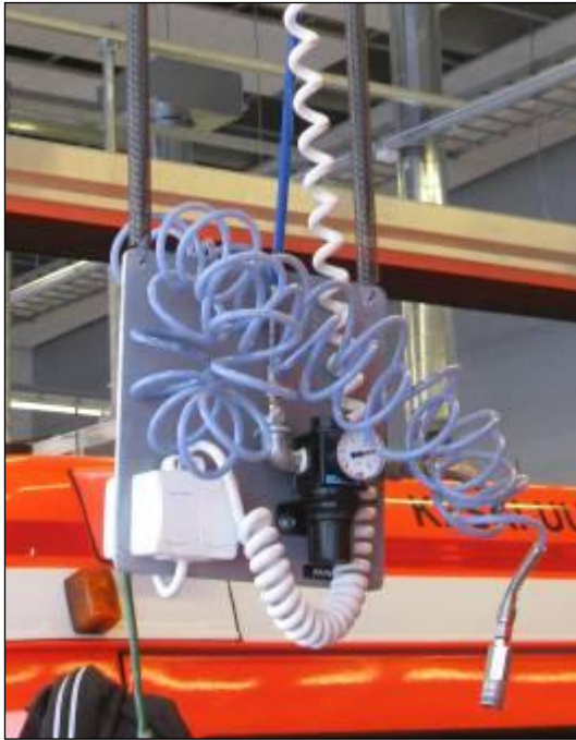
KUVA 20. Paineilma- ja sähköpisteet erikseen tuotuna
