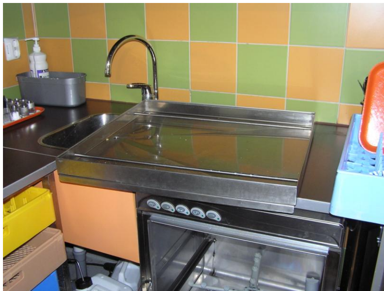
KUVA 11. Kahvion astianpesutilan valutuskaukalo (Niemelä 2012)
