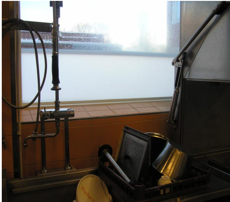
KUVA 32. Ikkunan suojakalvo alareunassa (Niemelä 2012)
