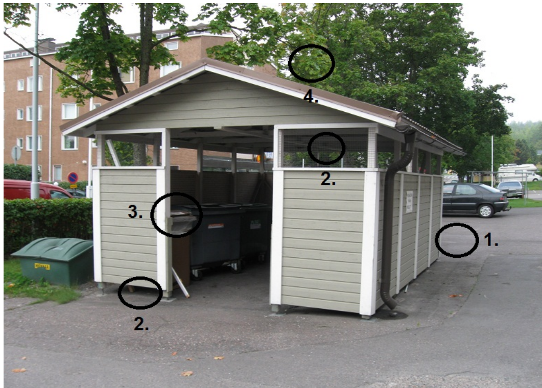
KUVA 3. Kuva tyypillisestä jätetilasta
