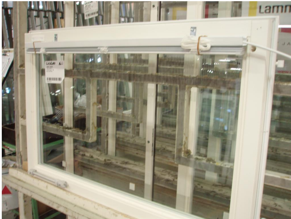
KUVIO 5. Sälekaihdin kiinnitettynä sisäpuolteeseen.
