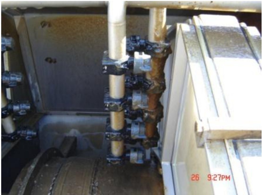
KUVA 18. Suodattimien pesusuuttimet Valokuva M. Rytönen
