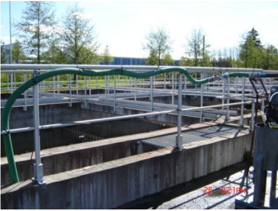
KUVA 4. Veden syöttöletku pumpulta laitteistolle. Valokuva M. Rytönen
