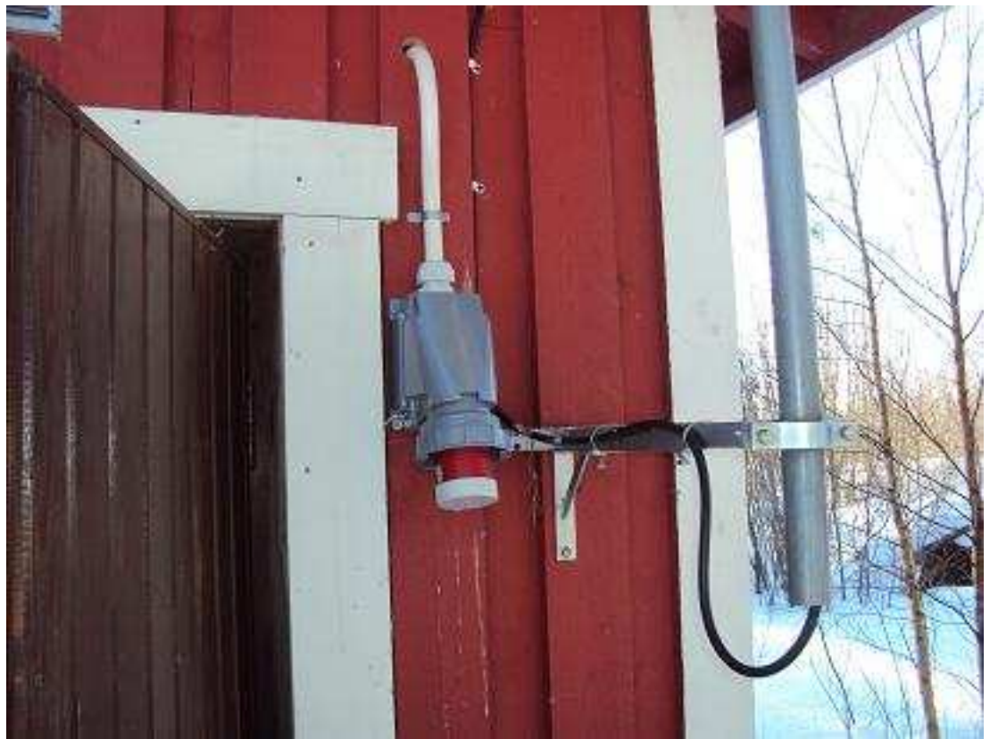
Kuva 9. Kojevastake asennettuna Uimaharjun siirtopumppaamon ulkoseinälle.
