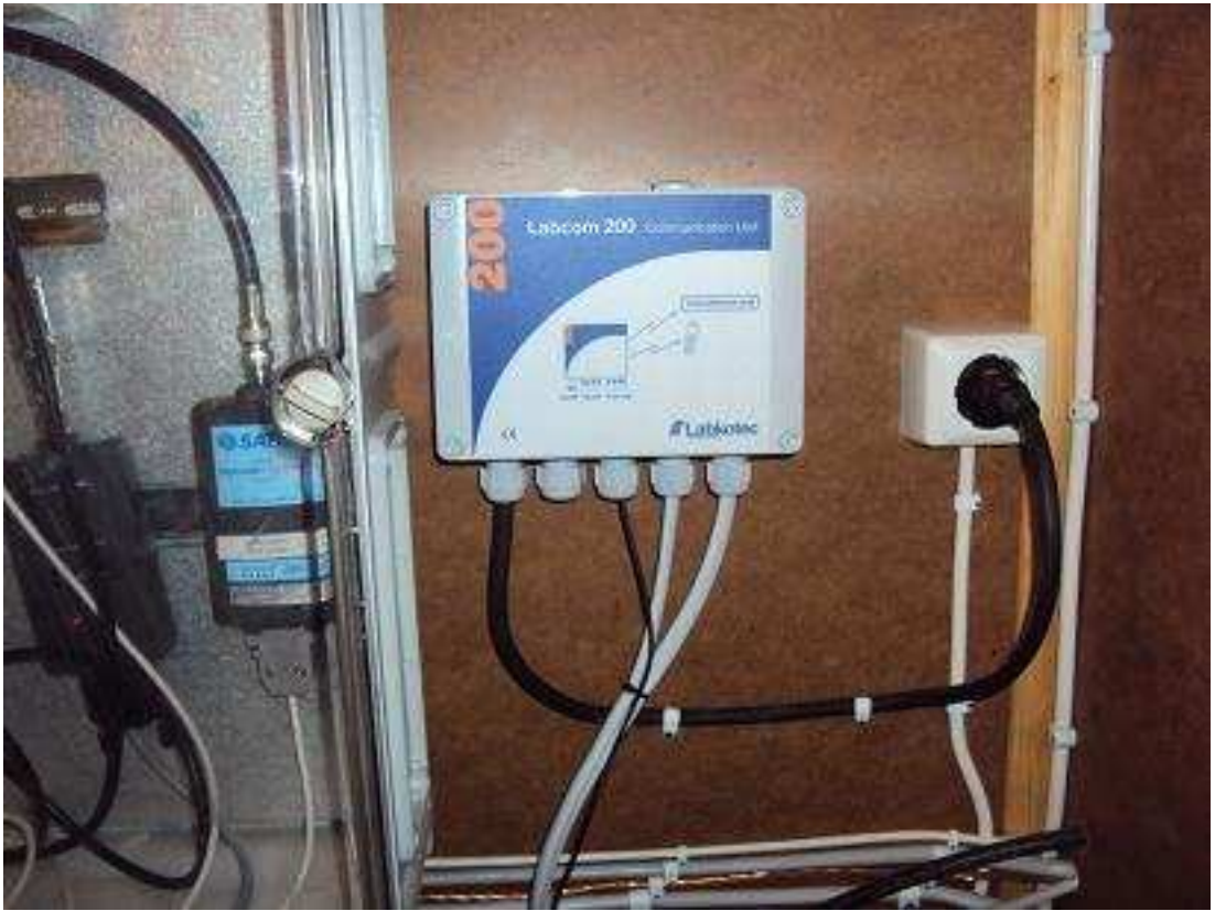
Kuva 6. Labcom 200 tiedonsiirtolaite asennettuna sähkötyötilaan.
