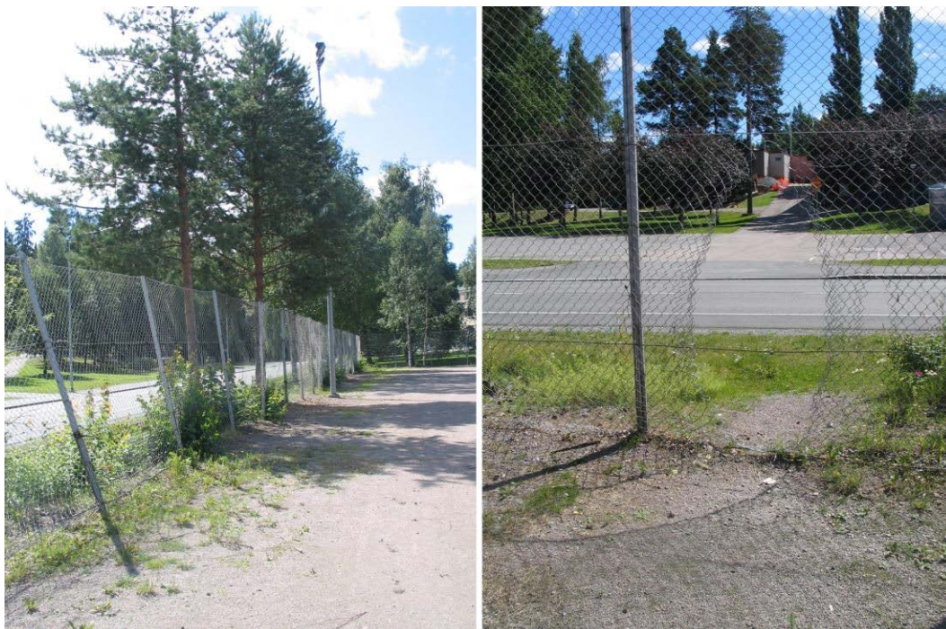
KUVIO 28. Nykyinen aitaus voi olla lapsille vaarallinen, minkä lisäksi se on osittain tielle päin kallellaan (Hyvönen 2011)
