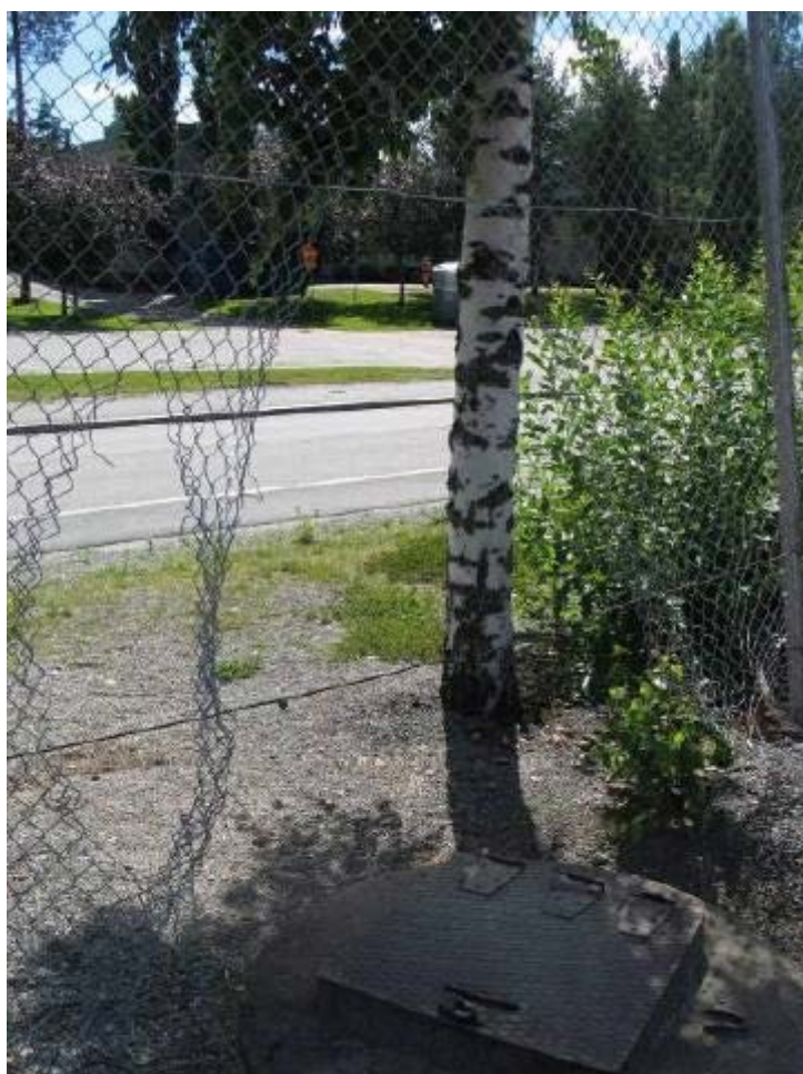
KUVIO 14. Lentävänniemen kenttää ympäröivä aita on osittain pahasti vaurioitunut (Hyvönen 2011)
