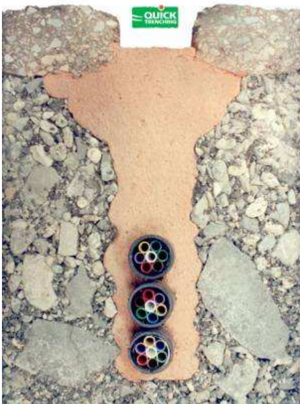
Kuva 9. Poikkileikkaus mikro-ojasta (Alpitel 2012.)
