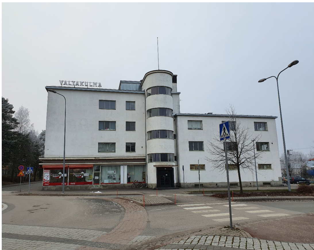
Kuva 1. Valtakulma-rakennuksen julkisivu talvella 2021
