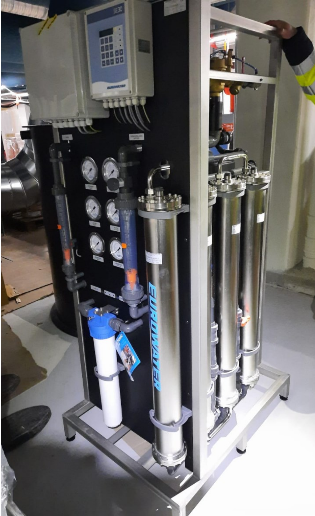
KUVA 8. Eurowater SM62/b1-4 -paketti työmaalla
