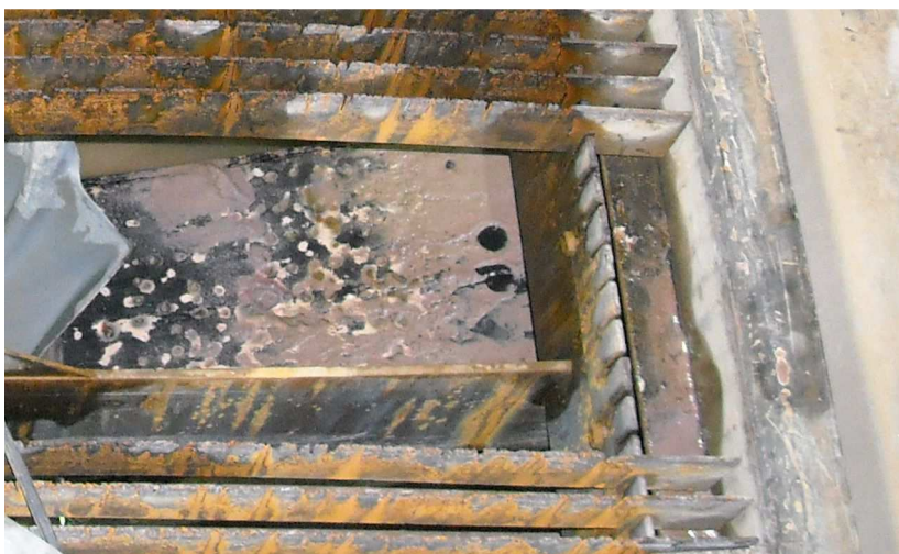
Kuva 19. Altaan lamellit kiinnitettynä kamppoihin /1/
