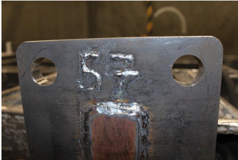
Kuva 17 Siltakohtaisen numeron hitsaaminen
