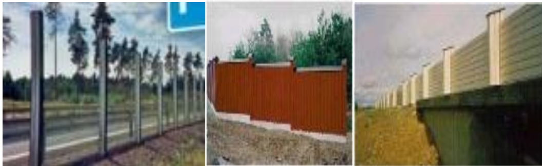
KUVA 3. Läpinäkyvä, puinen ja muovielementeistä valmistettu meluseinä (Trafino)
