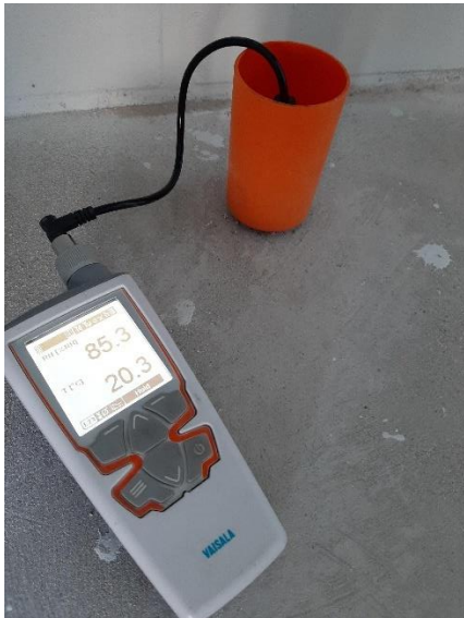
Kuva 30. Betonin suhteellisen kosteuden mittaus.
