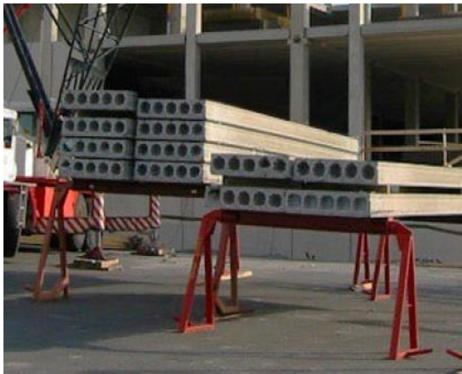
Kuva 17. Ontelolaattojen varastointi työmaalla (Heiska, Koskenvesa & Mittaviiva 2010).
