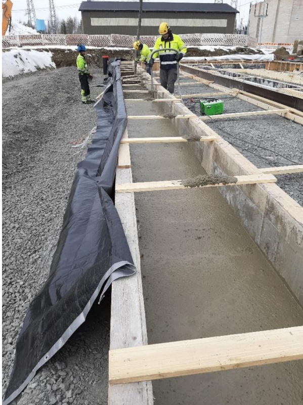
Kuva 3. Nauha-anturan valutyö
