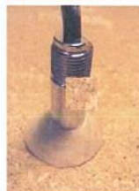
6d. Mittapään tiivistys betonipinnan tasolta katkaistussa mittausputkessa.
