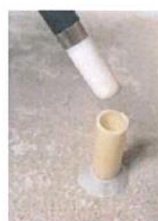
6a. Mittapää asennetaan reikään yleensä 3 vrk kuluttua reiän porauksesta ja tiivistyksestä, tai kun muuten tiedetään porauksen vaikutuksen riittävä poistuminen. Mittausputken pään vesihöyryntiivis kitti avataan ja mittapää asennetaan riipeästi putken porareian pohjalle.
