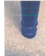
Kuva 4. Porareikämittauksen reikien tiivistys ja suojaus.
