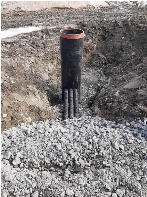
Kuva 2. Salaoja- ja sadevesiputkistot
