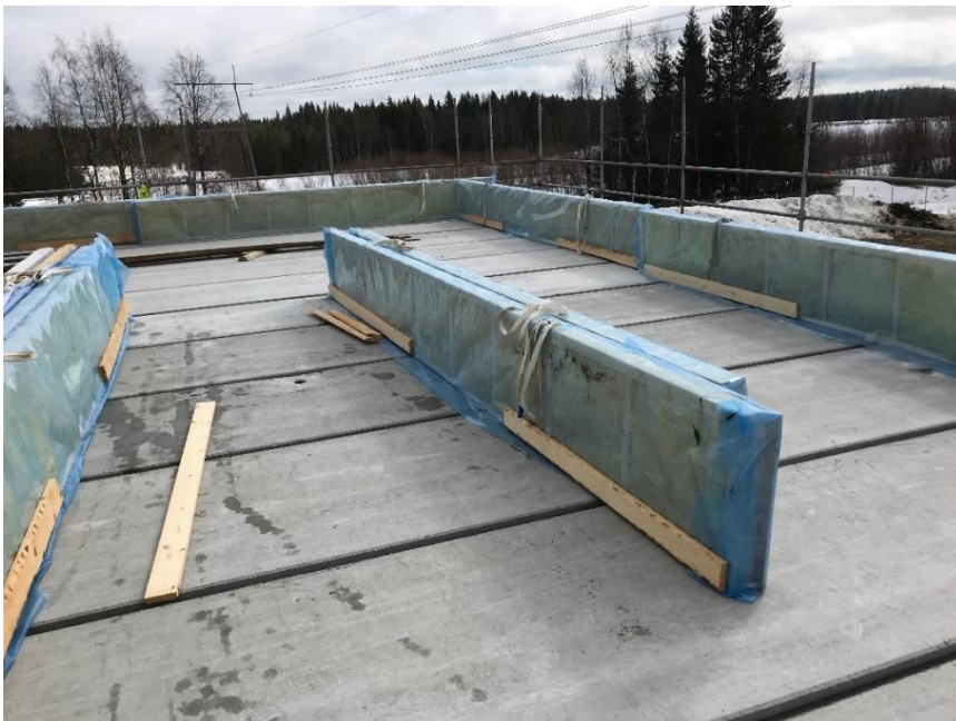
Kuva 6. Ontelolaatat asennettuina
