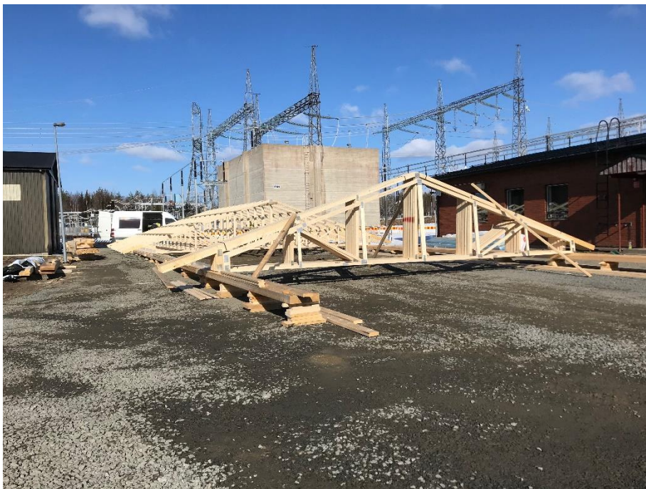
Kuva 7. Vesikaton rakentamista
