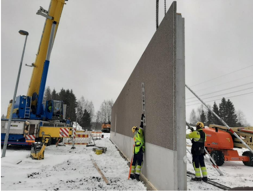
Kuva 5. Seinäelementtien asennusta
