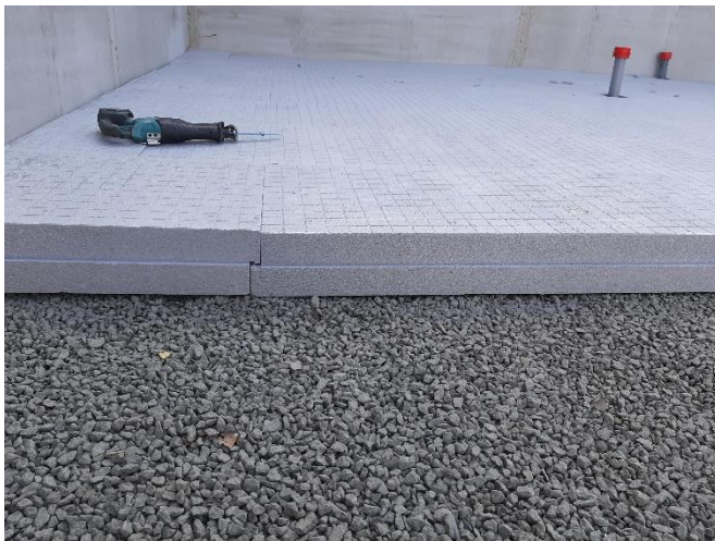
Kuva 8. Lattiaeristeen asennus
