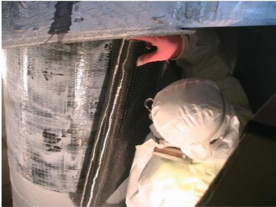
Kuva 25. Hiilikuitumaton levitys korjatun paalun ympärille (Helsingin satama 2012.)
