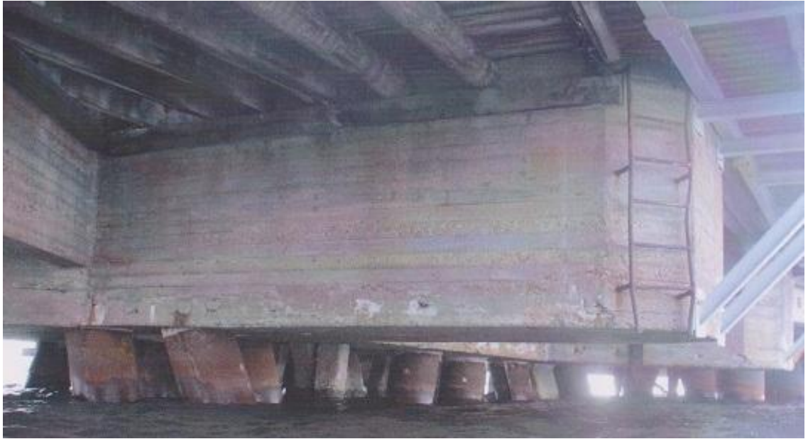
Kuva 18. Tiheään asennetut paalut (Kotkan Satama 2012.)
