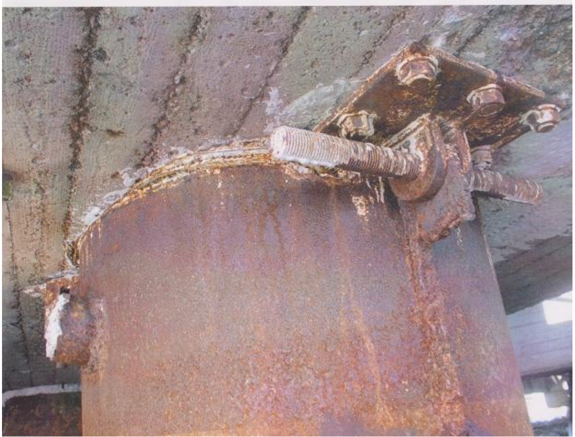
Kuva 17. Valmis teräsmantteli (Kotkan Satama 2012.)
