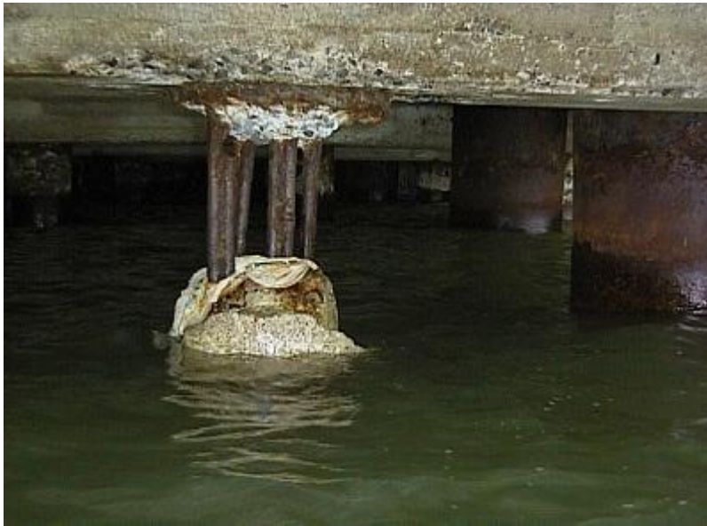
Kuva 22. Vaurioitunut paalu (Powermortar 2012c.)
