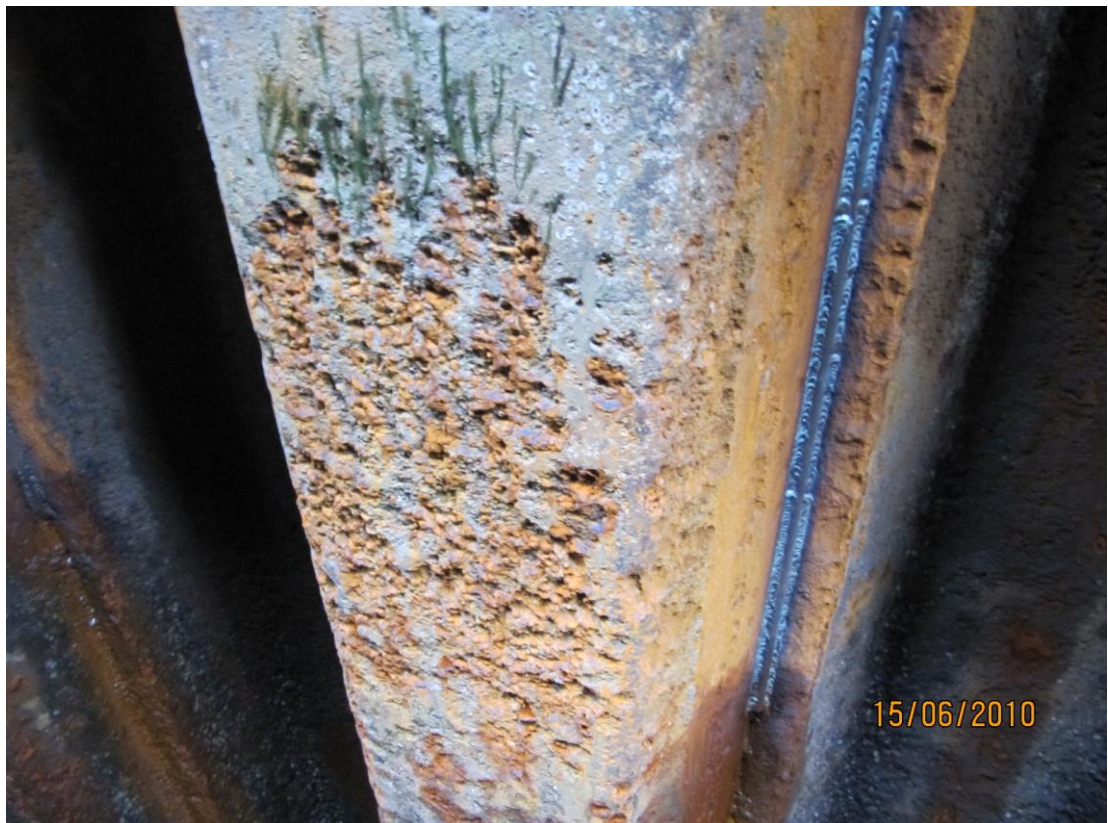
Kuva 28. Erittäin pahasti pistemäisesti ruostunut teräsponttiseinä (Saukkonen 2012.)
