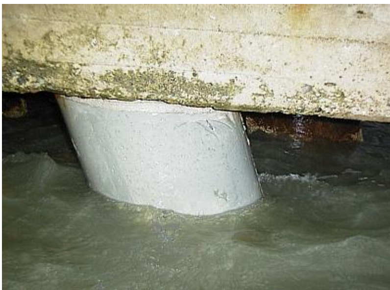
Kuva 23. Voimalaastilla korjattu paalu (Powermortar 2012c.)
