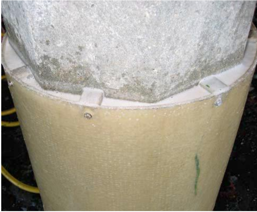
Kuva 20. Lasikuitumuotin avulla korjattu teräsbetonipaalu (Denso 2012d.)
