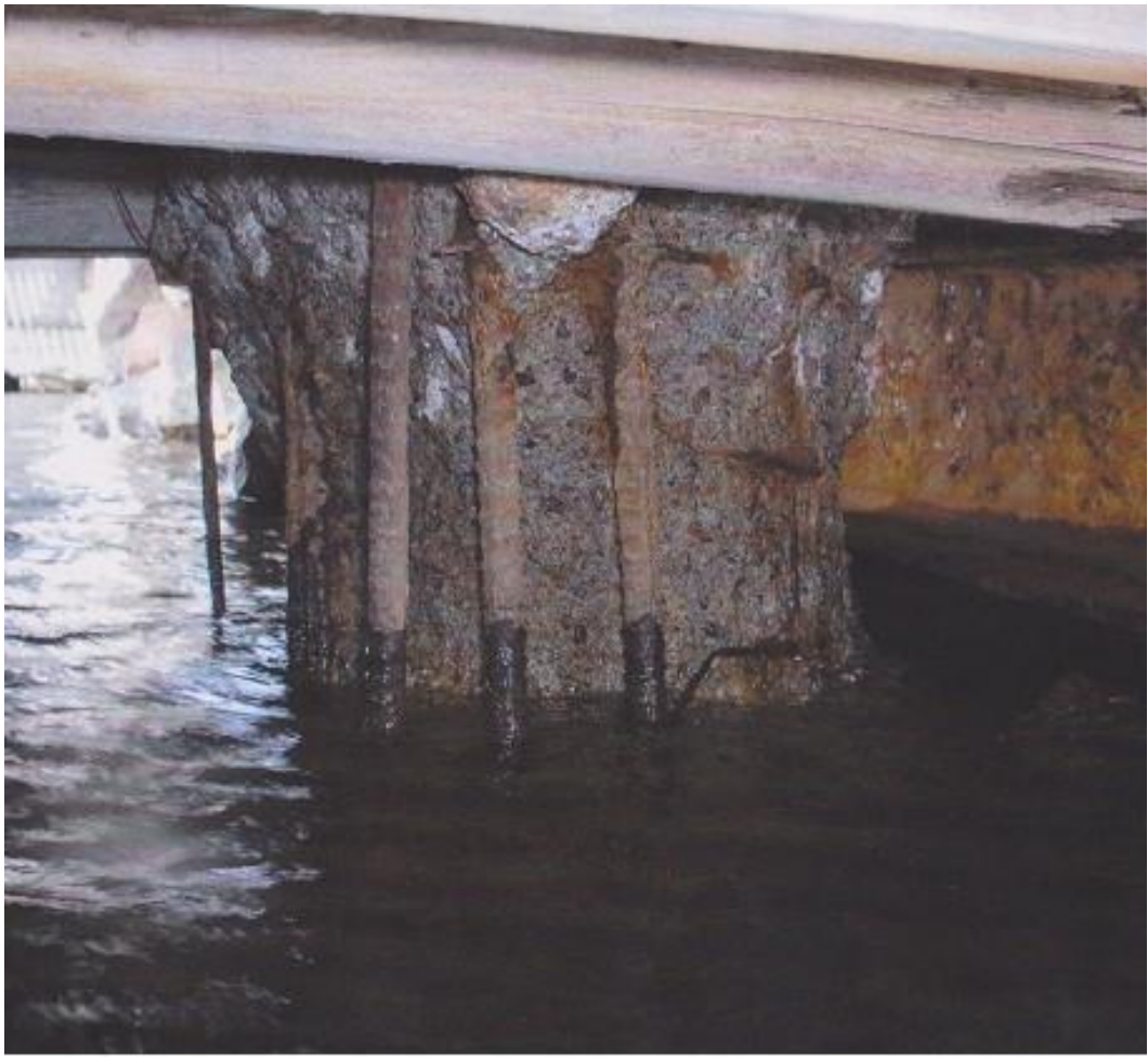
Kuva 11. Vaurioitunut teräsbetonipaalu (Kotkan Satama 2012.)
