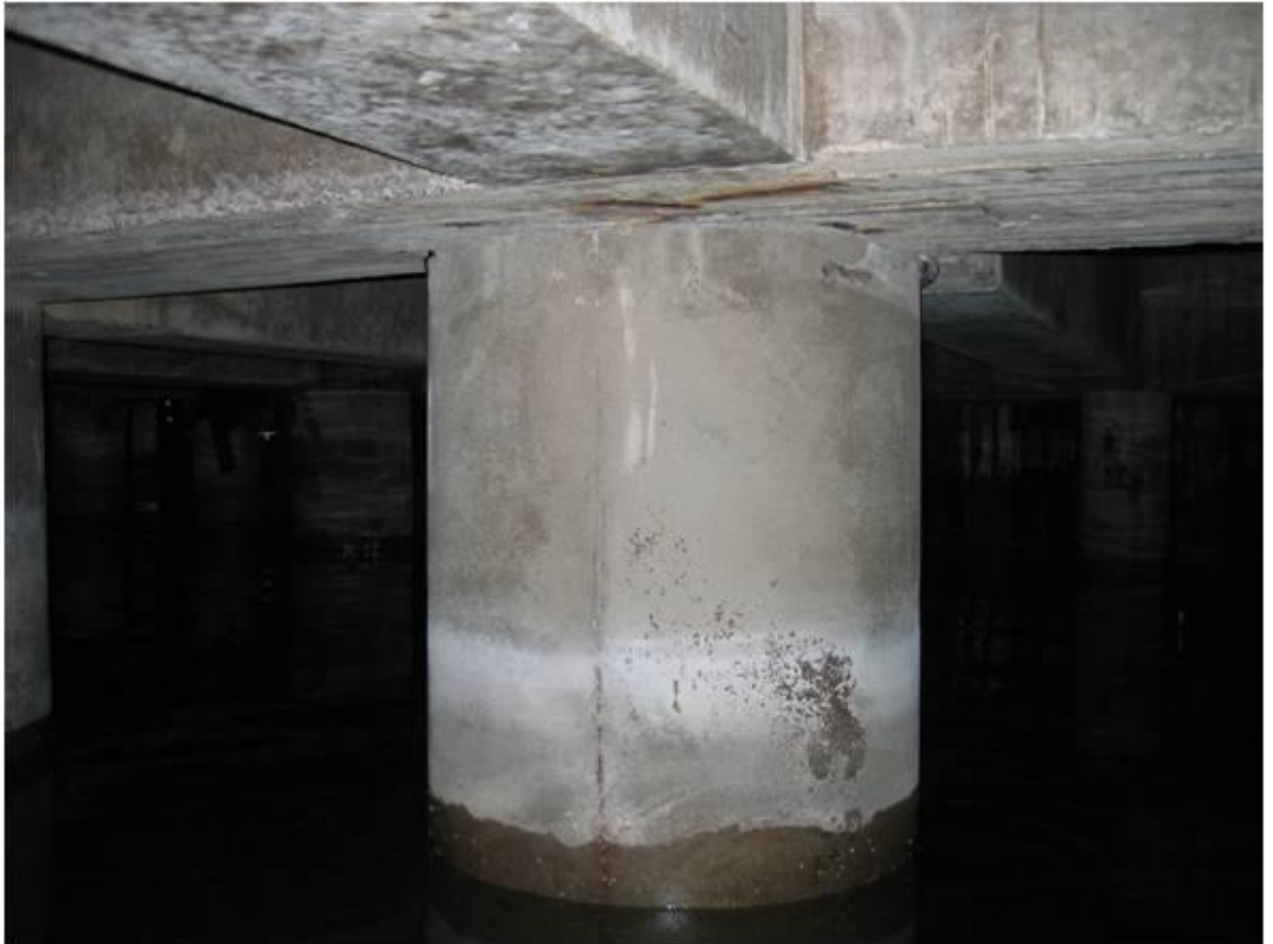
Kuva 12. Betonimantteloinnilla korjattu (Helsingin Satama 2012.)
