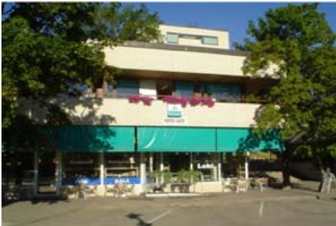
Figur 2. Tili Sydwest Oy Ab:s kontor på Köpmansgatan i Pargas
