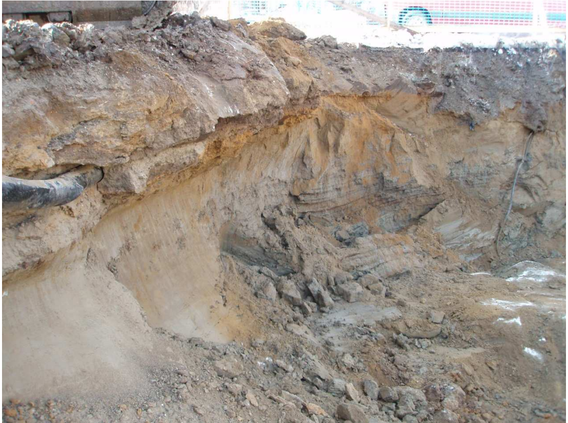
KUVA 4. Liian jyrkkä maaluiska, joka on sortunut maan sulamisen takia. Kuva Marko Niiranen 2012
