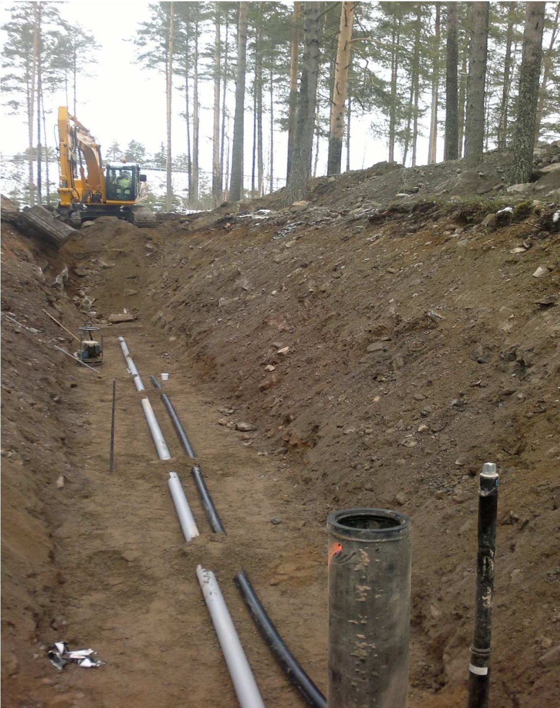
Kuva 3. Syvä kaivanto, jonka sortumavaara on ehkäisty riittävän loivilla luiskilla. Kuva Marko Niiranen 2012
