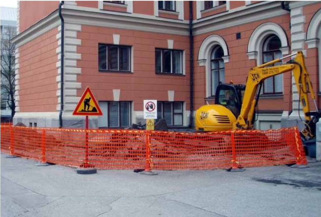
KUVA 5. Siisti työkoneen varo-alue. Ulkopuolisten pääsy työmaa-alueelle on estetty. Kuva Marko Niiranen 2012
