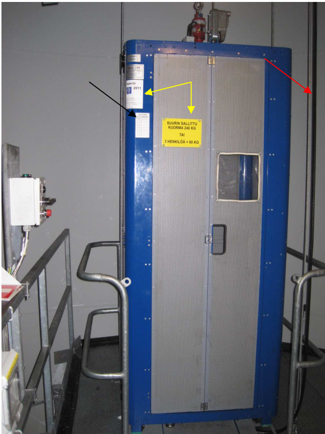
Kuva 6. Henkilönostimen kori turvamerkintöineen
