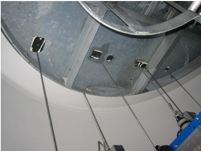
KUVA 4. Nosto-, ohjaus- ja tarrainvaijerit
