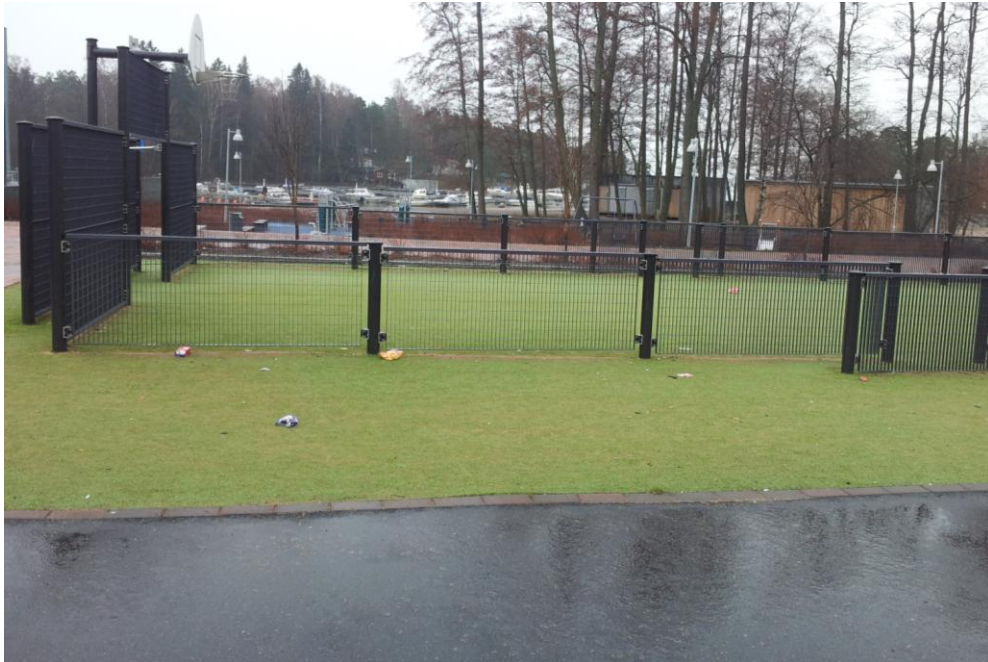
Kuva 17: Etualalla näkyy asfaltoitu rata ja takana monitoimikenttä
