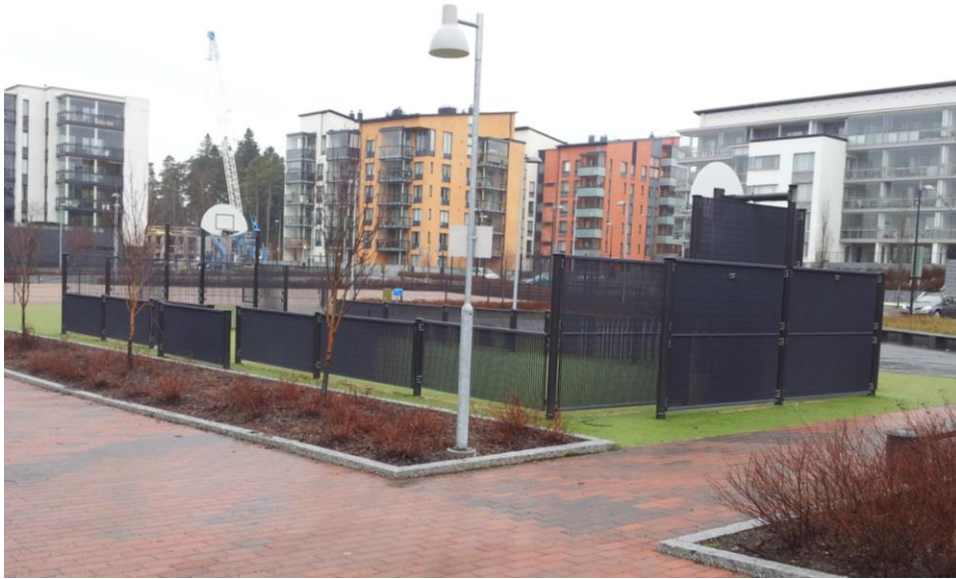
Kuva 18: Peliareena ja takana asfaltoitu rata
