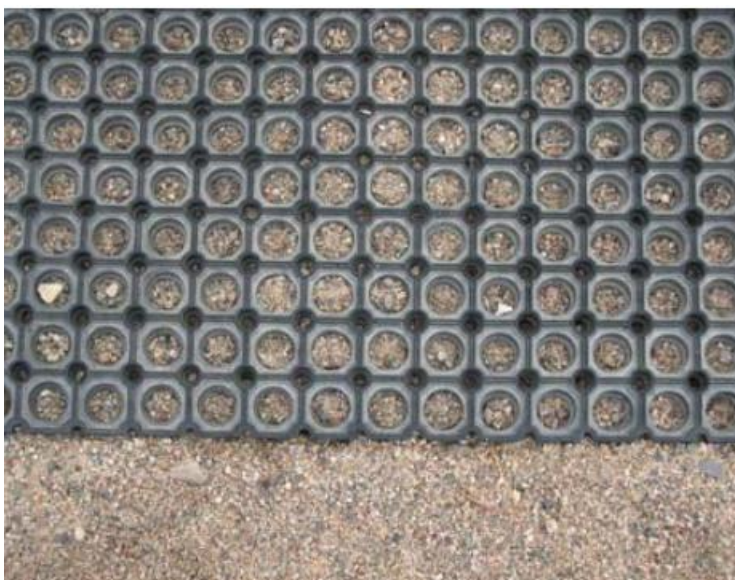
Kuva 11: Kumimatto ja hiekkaa turva-alustana
