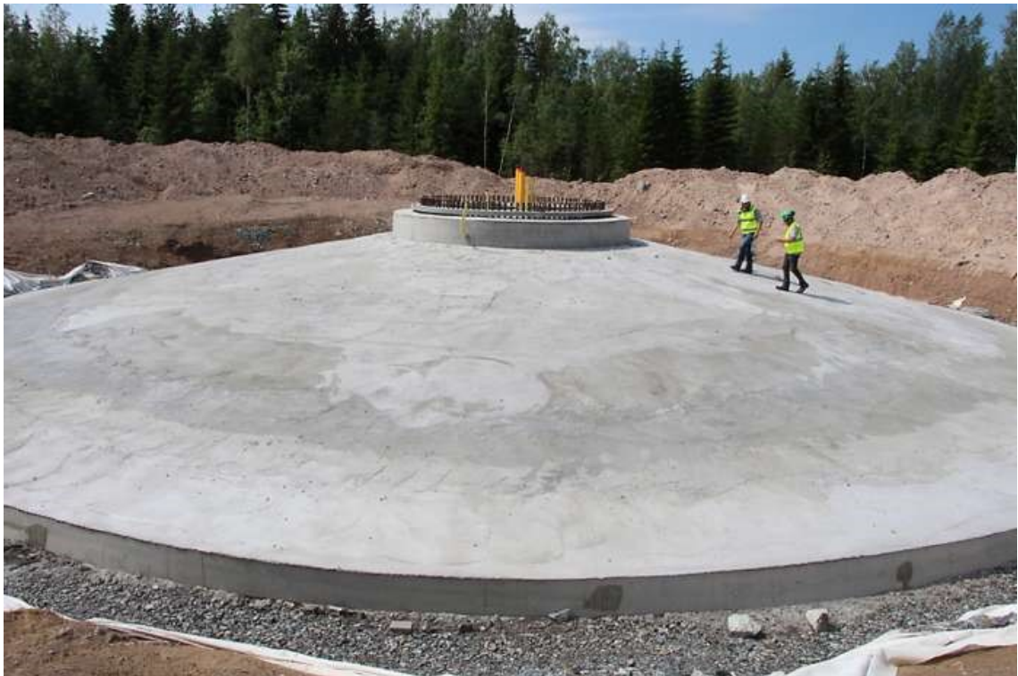
Kuva 10. Tuulivoimalan betoninen perustus Verhonkulman tuulivoimapuistossa Marttilan kunnassa Varsinais-Suomessa [25].
