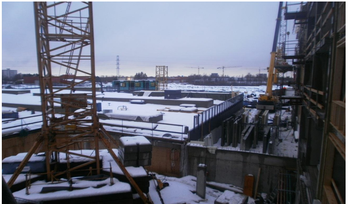
Kuva 8. Torninosturin ulottuvissa oleva elementtifakki, johon osa kuormista joudutaan purkamaan autonosturilla.
