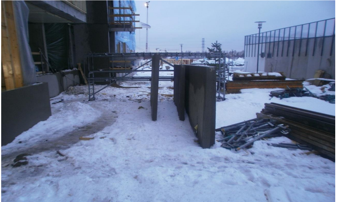
Kuva 6. Työmaa-alueeksi lainattu pyörätie, jota käytetään varastointiin.
