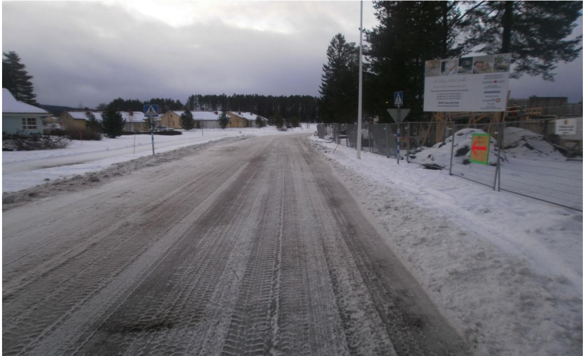
Kuva 21. Näkymä Katinkullantieltä työmaan liittymää kohti
