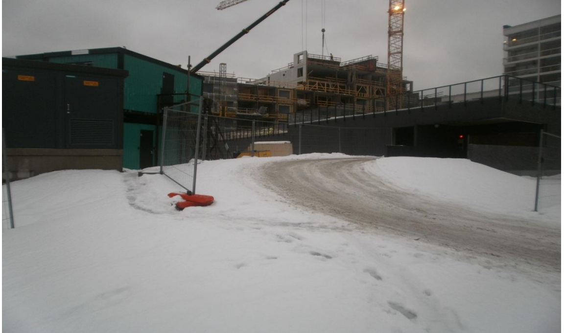
Kuva 7. Parkkihallin sisäänkäynnin luiskan ja Rajakaltionkadun liittymäkohta.
