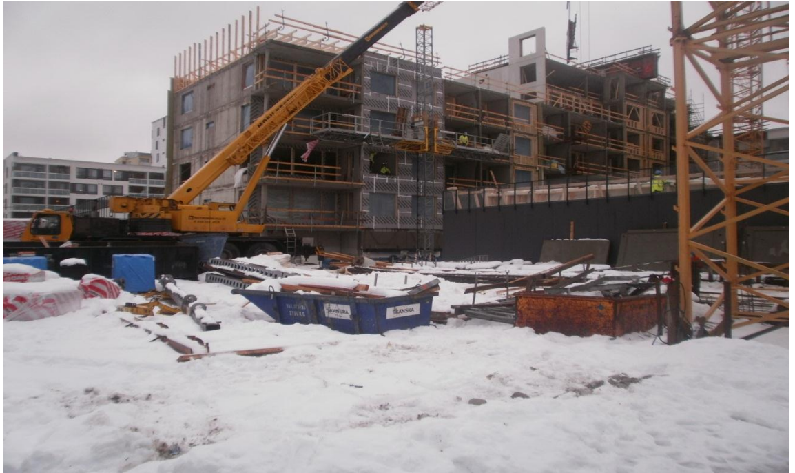
Kuva 9. Elementtikuorman purku tapahtuu osittain autonosturin avulla.
