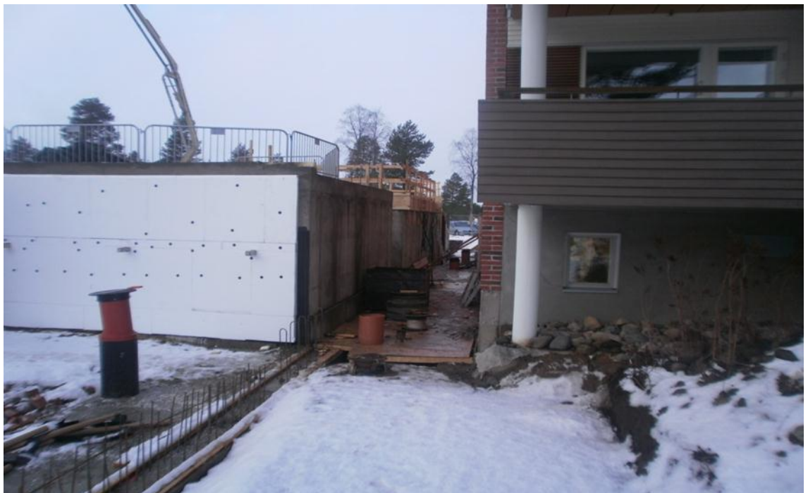
Kuva 20. Tulevan rakennuksen ja vanhan siiven liittymäkohta.
