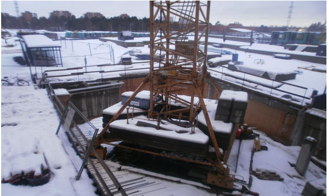
Kuva 5. Torninosturille on varattu paikka aiemmin valmistuneesta parkkihallista.
