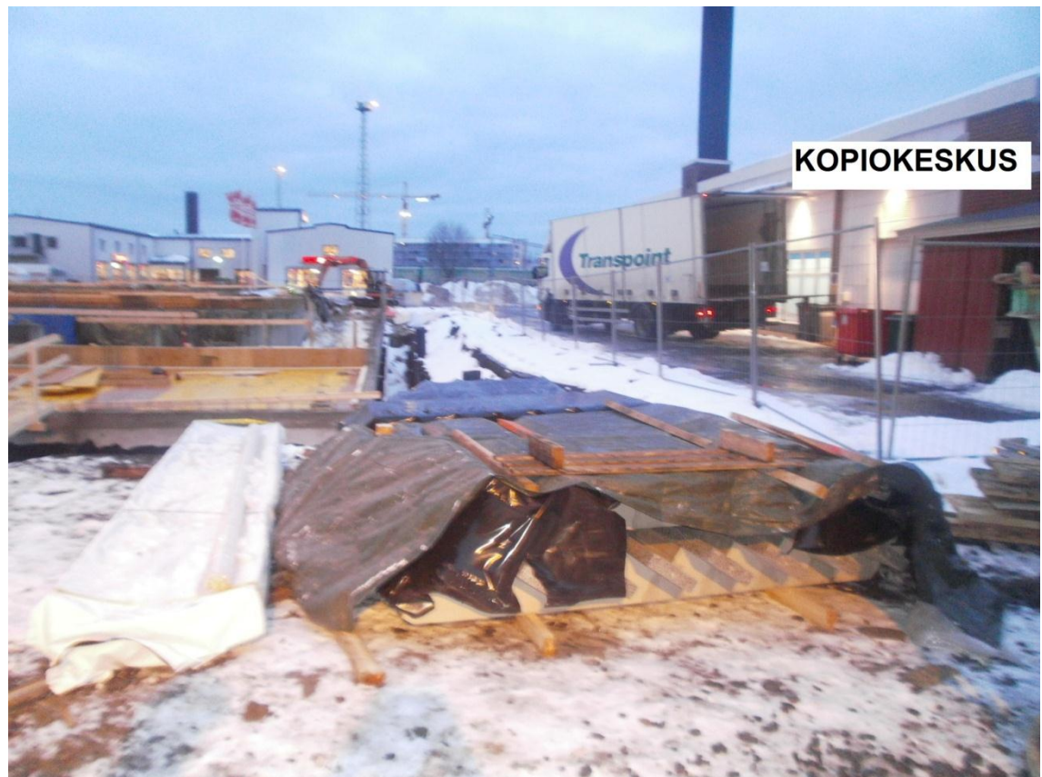
Kuva 17. Työmaan ja kopiokeskuksen liittyminen toisiinsa.
