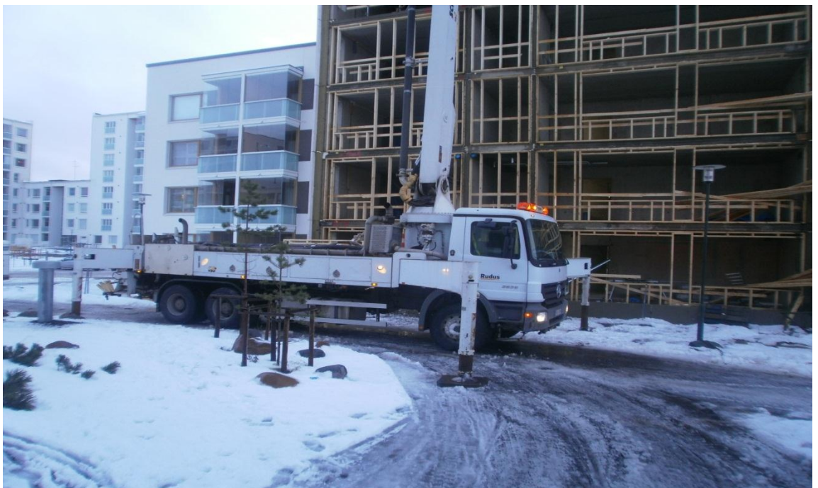
Kuva 10. Pumppuauton vaatima tila.
