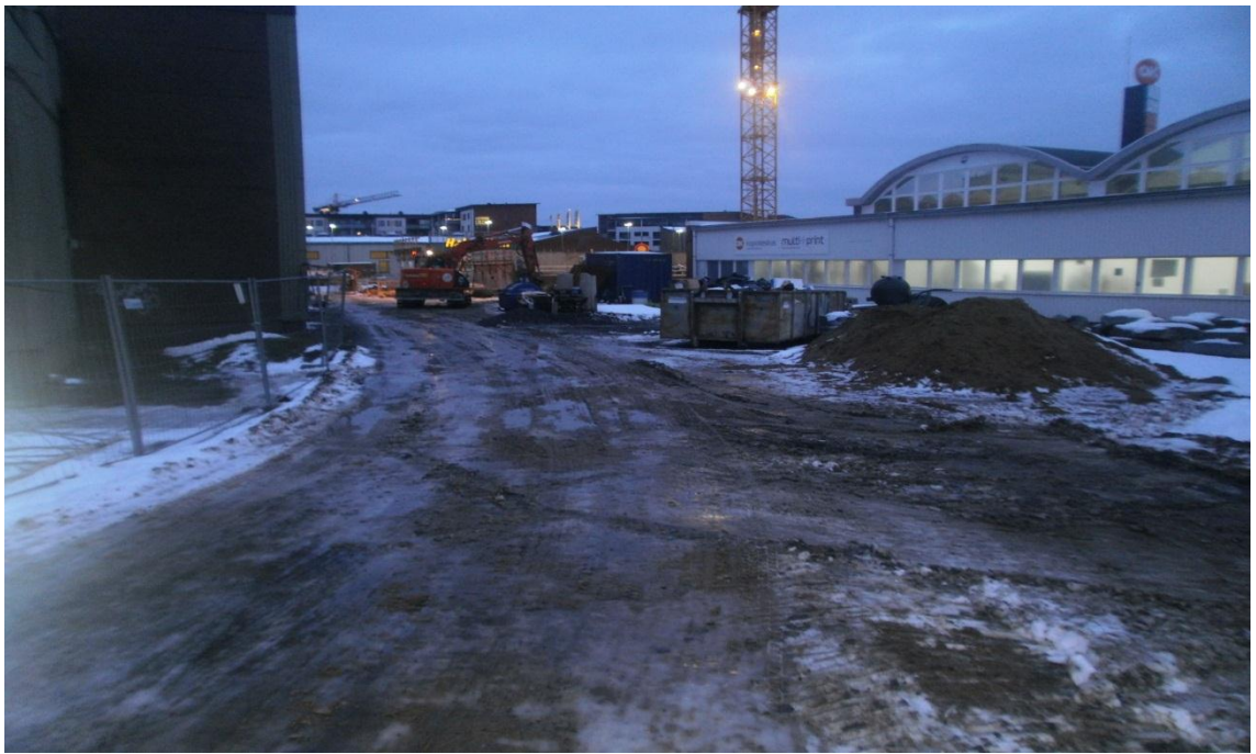
Kuva 13. Työmaan läpi kulkeva ajoreitti.
