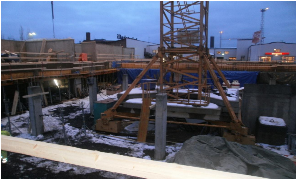
Kuva 16. Torninosturin sijoituspaikka keskeisesti parkkihalliin nähden.
