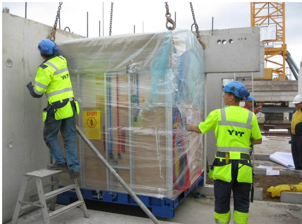
KUVIO 4. Kylpyhuone-elementtiä asennetaan paikoilleen
