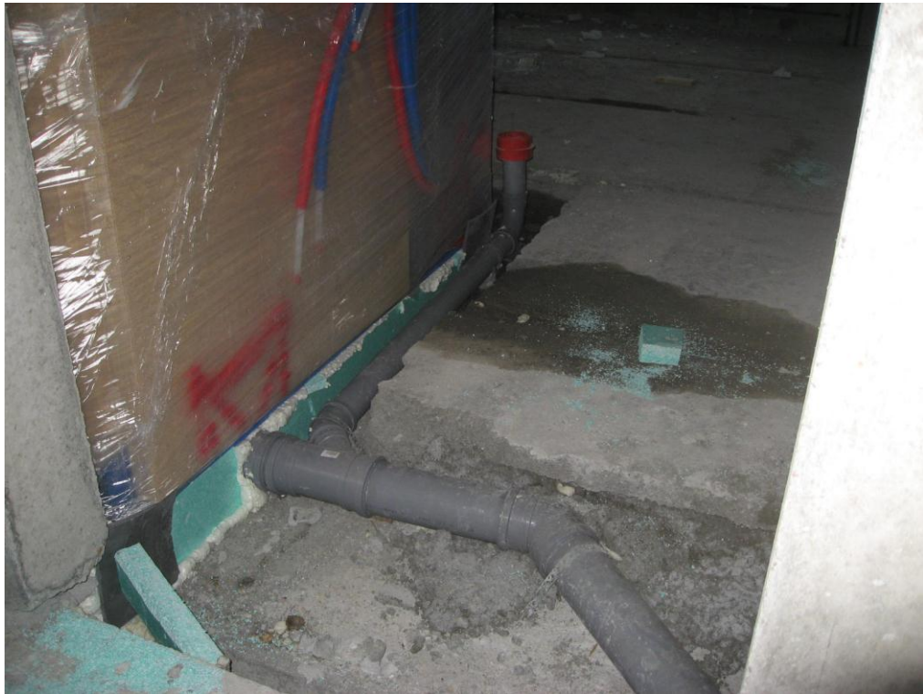
KUVIO 5. Kylpyhuone-elementin viemärin liitos talon runkolinjaan.
